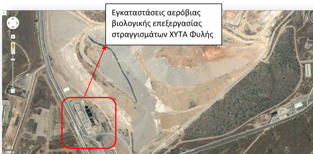
Εικόνα 3: Εγκαταστάσεις ΧΥΤΑ Φυλής (πηγή: Google Earth)
