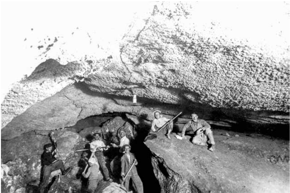
128 - 1936: Lavori all'interno della Grotta della Spipola: i "minatori" stanno eliminando i massi che chiudono il fondo della prima sala della cavità, oltre la quale verranno costruite la seconda e la terza rampa di scale. A sinistra Giulio Greggio, a destra Luigi Fantini. Foto L. Fantini - Archivio GSB-USB.
