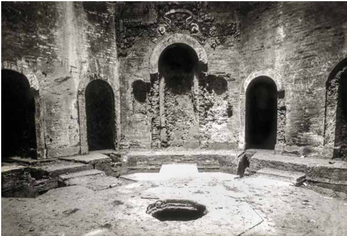
219 - 1942: la sala ottagonale della Conserva di Valverde, meglio nota come “Bagni di Mario”, costruita nel 1563 per la captazione delle acque destinate all’alimentazione delle fontane situate nel centro storico di Bologna. Foto L. Fantini - Archivio Storico GSB-USB.
