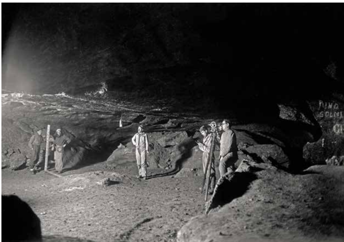
132 - Dicembre 1936: Grotta del Farneto, Sala del Trono: il rilevamento topografico del piano superiore della cavità. Da sinistra, alla stadia, Vittorio Braiato e Vico Greggio, al centro Luigi Fantini, Giulio Greggio che trascrive i dati e Vittorio Martinelli (Tolo) al tacheometro. Foto L. Fantini - Archivio GSB-USB.
