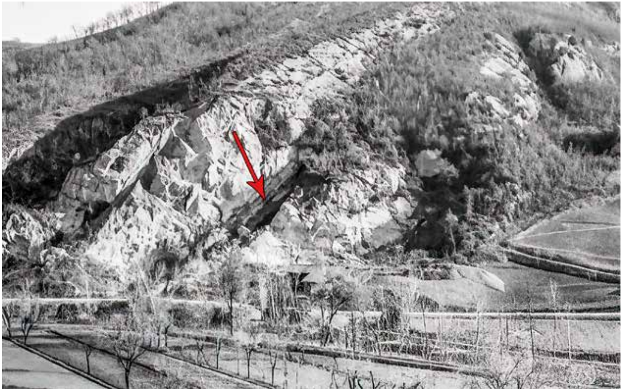
16 - Come si presentava la collina gessosa del Farneto negli anni '30 del Novecento. La freccia indica l'ingresso del Sottoroccia prima della sua distruzione provocata dai lavori di cava. Foto L. Fantini - Archivio GSB-USB.
