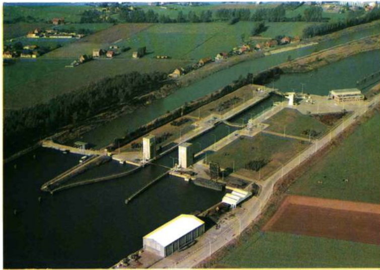
Sluis te Zemst
