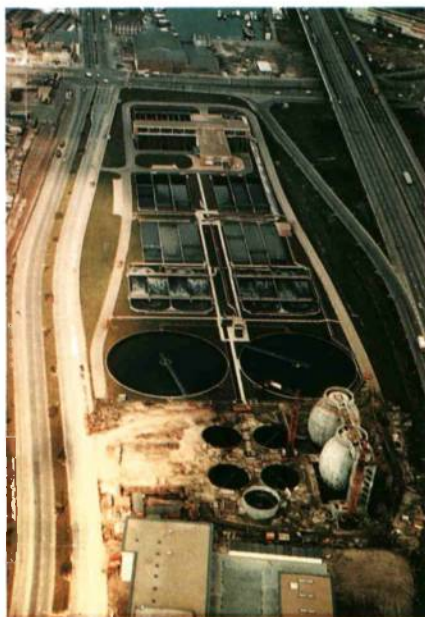
Waterzuiveringsstation Schijnpoort Antwerpen
