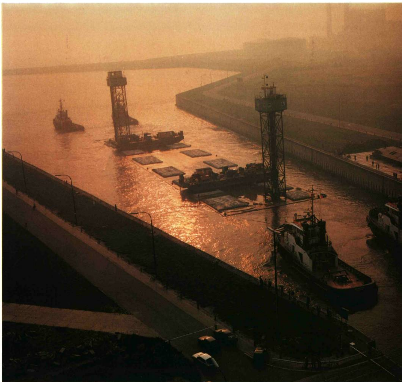
Liefkenshoektunnel. Afzinken tunnelelement (Luchtfoto G. Coolens Antwerpen)
