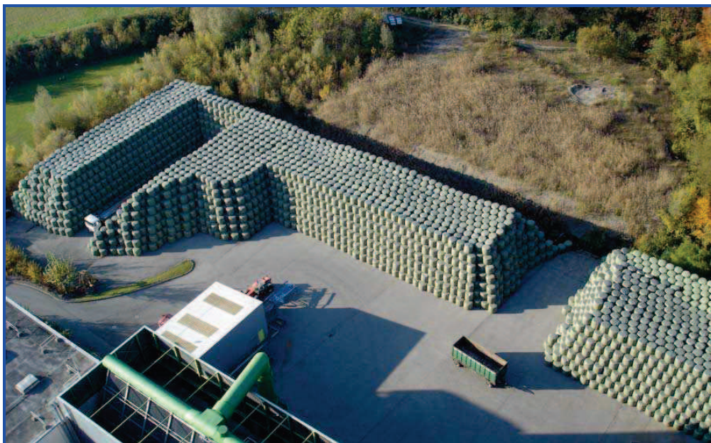
Rysunek 35 Przedstawienie sposobu okresowego składowania nadmiarowych ilości odpadów (Źródło: KVA Buchs (CH))
