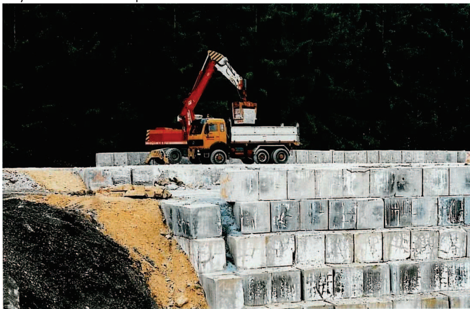
Rysunek 39 Deponowanie zestalonych pozostałości z odpylania spalin i pyłów lotnych z kotła (Źródło: KVA Winterthur, Szwajcaria)
