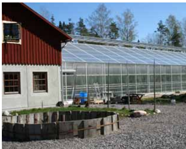
Växthus med hög standard för ekologisk tomatodling. Vattenburen värme, även i jorden, ochnockventilation ger goda möjligheter till klimatreglering och därmed ett bra odlingsresultat. Foto: Christina Winter.
