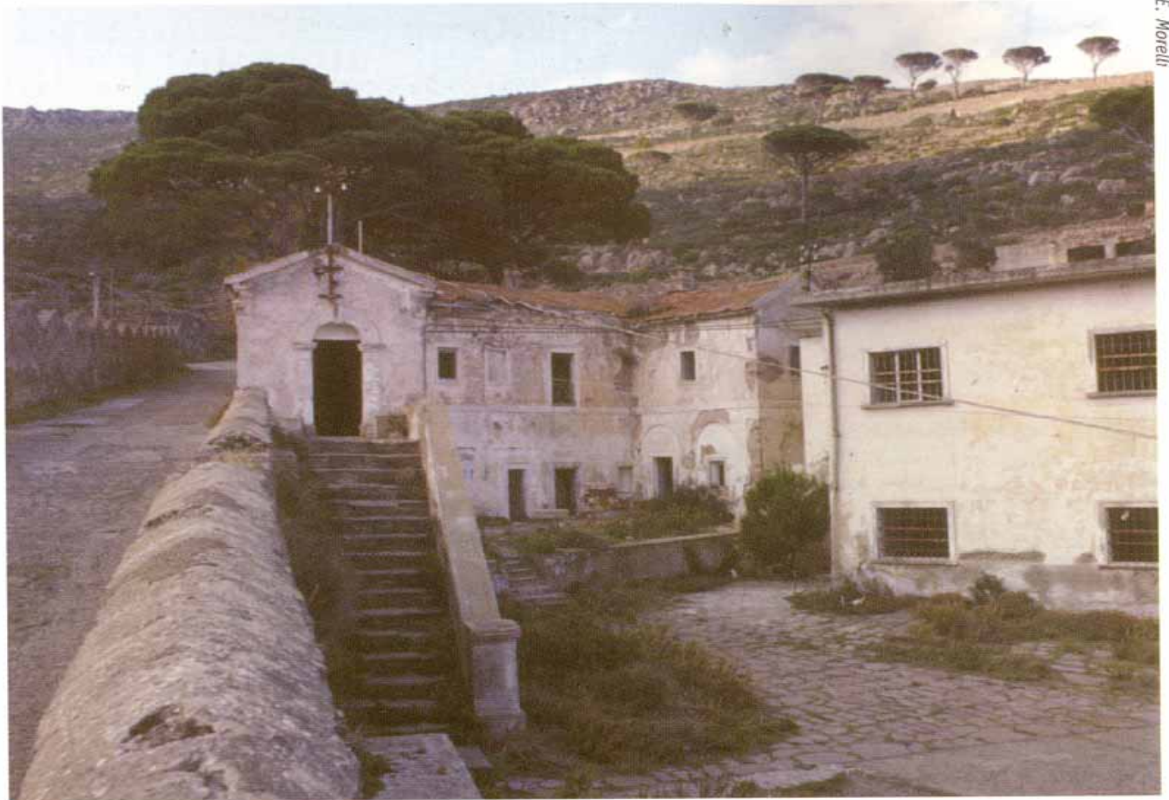
Edifici del carcere
