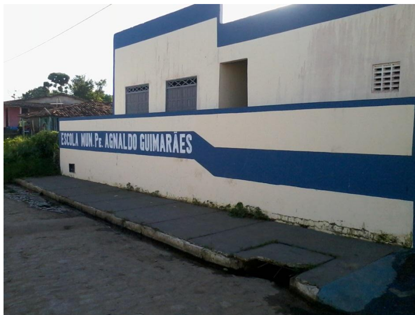
Figura 111: Lançamento de esgoto inadequado na zona rural de Propriá. Fonte: Gesois, 2014.
