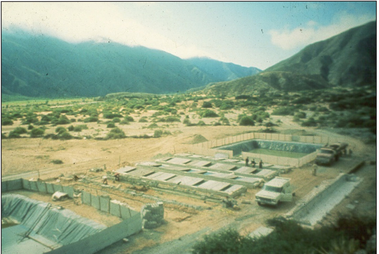
Figura 1: Fábrica con poza solar para tratamiento de sales.
