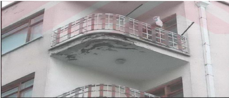
Şekil 8. Sıvada aşınma
