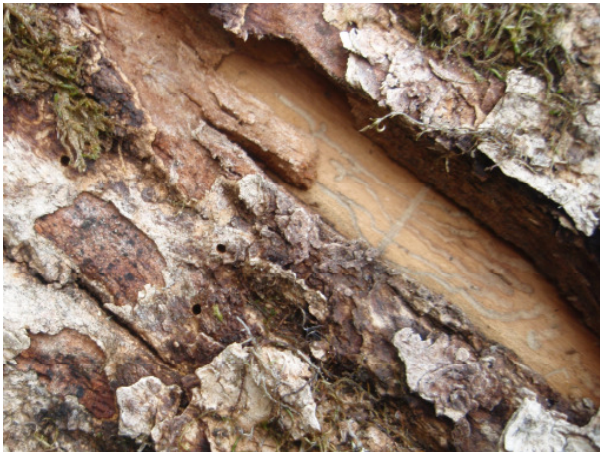
Bild 1: Bohrlöcher und Bohrgänge
