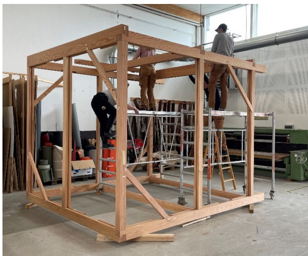
Stolpeværkskonstruktionen, uden tag og vægplanker. Læg mærke til de fine skråbånd med svalehaleblad.
