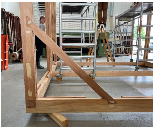
Stolpeværkskonstruktionen, uden tag og vægplanker. Læg mærke til de fine skråbånd med svalehaleblad.
