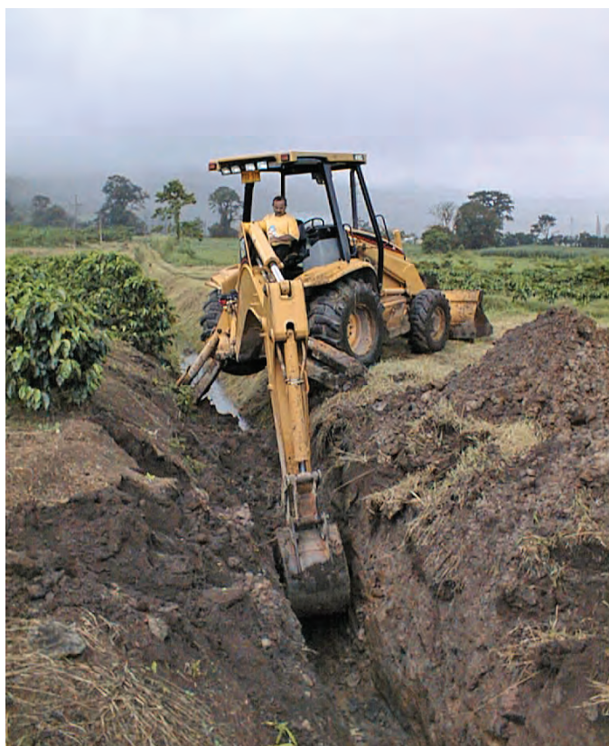
Figura 9. Mejoras del drenaje en límites exteriores de las parcelas del ensayo de largo plazo en sistemas agroforestales con café, Turrialba, Costa Rica, julio 2002. Foto: E. de M. Virginio Filho.
