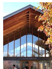
屋根のすぐ下に 三角の山が見える
