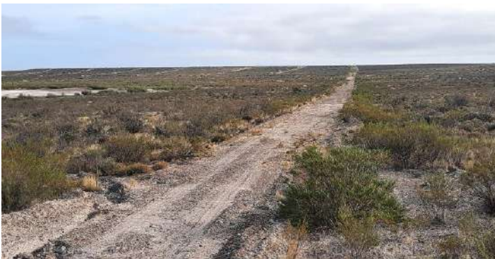
Fotografía 18. Surcos de erosión al borde del camino
