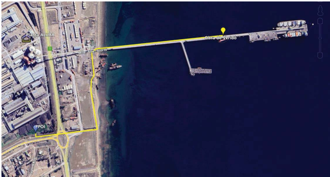
Figura 11. Imagen satelital ubicación de obra de descarga de salmuera al mar y cañería (traza amarilla) de salmuera. Fuente: Google Earth 2023.
