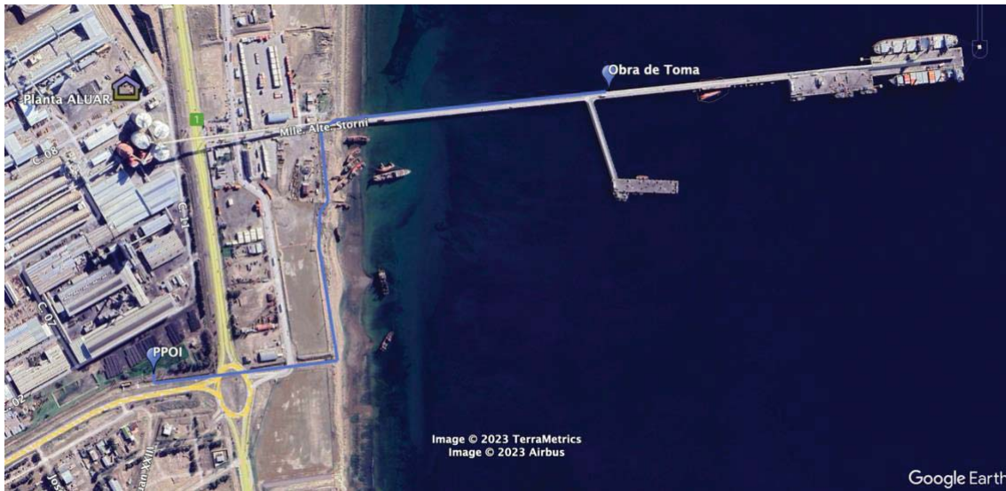
Figura 3. Imagen satelital ubicación de obra de toma de agua de mar y cañería (traza azul) de agua de mar hacia la PPOI. Fuente: Google Earth 2023.
