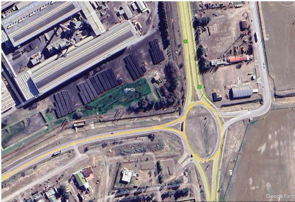
Figura 3. Imagen satelital del terreno sobre el que se construirá la PPOI. Abajo a la derecha de la imagen se observa la rotonda de intersección de la Ruta Nacional A010 y la Avenida Kenneth Woodley/Ruta Provincial N°1.
