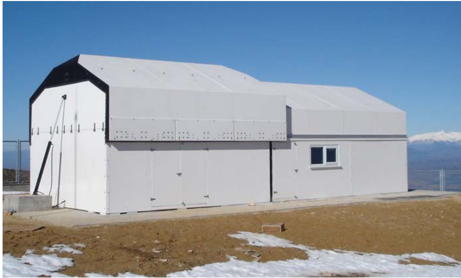
Fig. 4. Reinforced glass-fiber enclosure at Observatori Astronòmic del Montsec.
