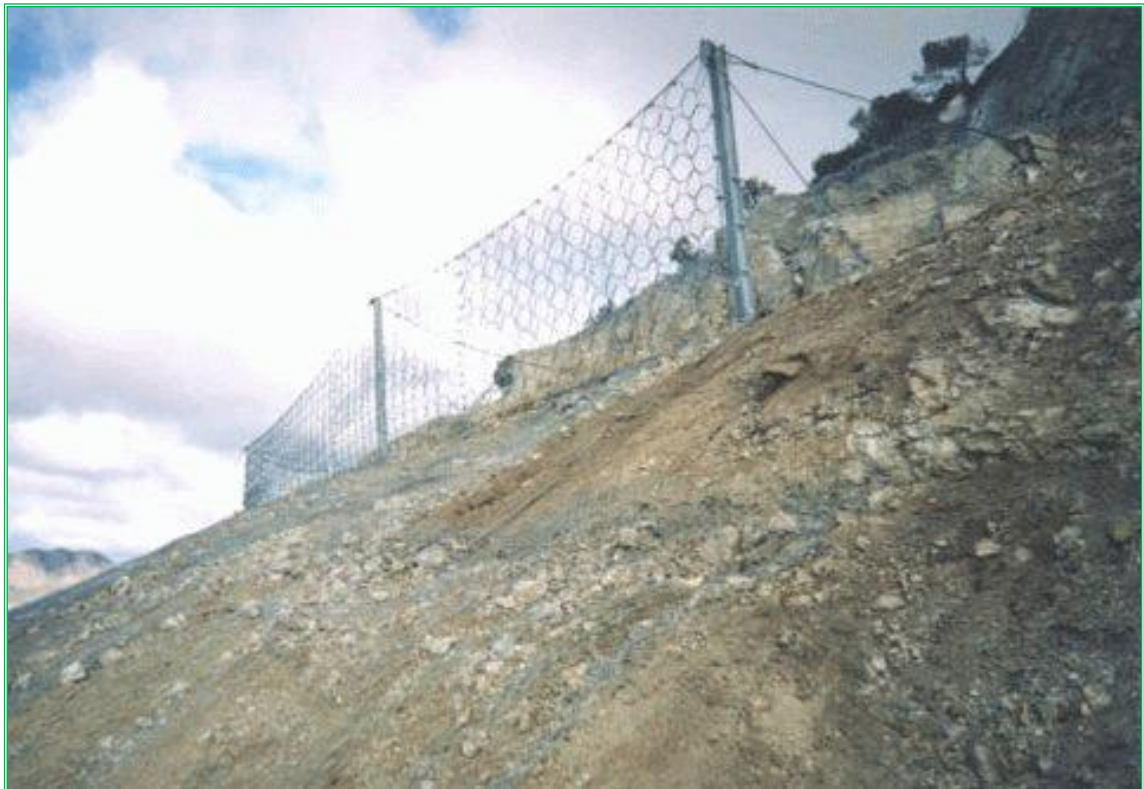
Imagen 57.- Vista de muro tipo
