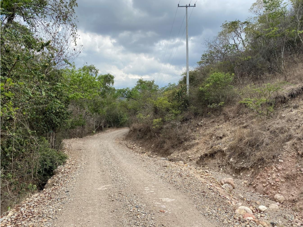
Imagen 48. Hábitats del SAR y Camino actual el cual será pavimentado.
