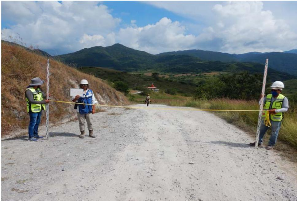
**Fotografía 15.-** Se puede observar el ancho del camino de 7.5 m en el km 3+000.
