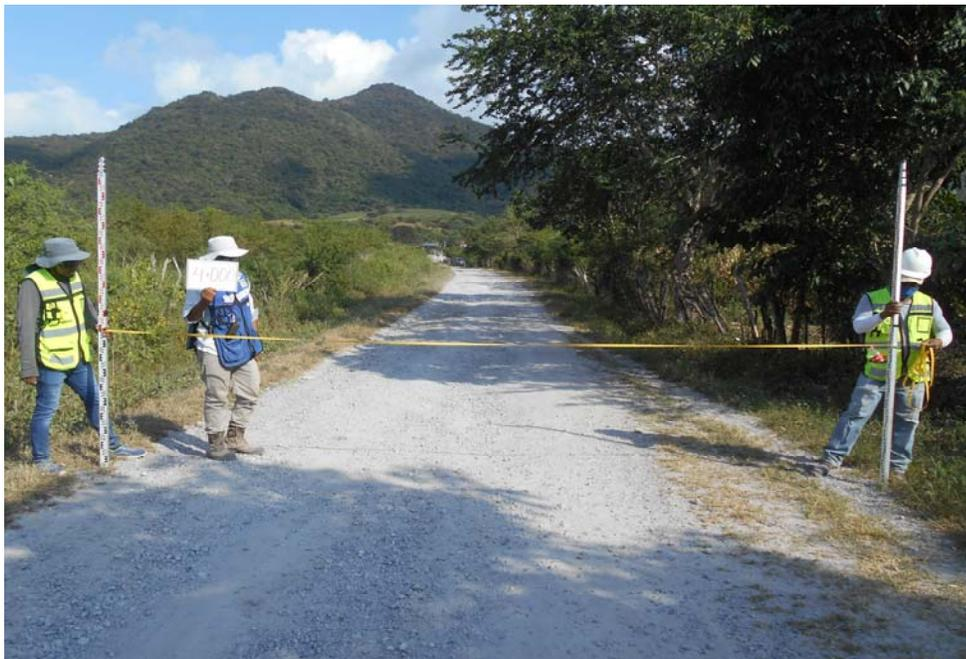
**Fotografía 20.-** Se observa el ancho del camino a modernizar de 11.6 m en el Km 4+000.
