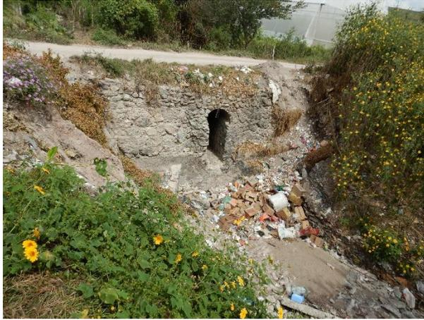
Imagen IV.5. Obra de drenaje 2, se aprecia la contaminación por residuos.
