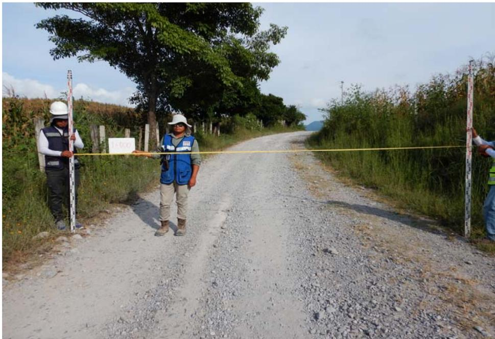
**Fotografía 6.-** Se aprecia el ancho de camino de 6 m en el Km 1+000.
