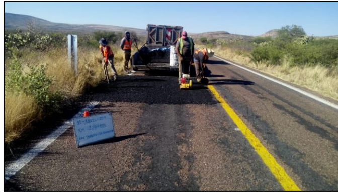
Figura II.35 Actividades de mantenimiento de una carretera similar.
