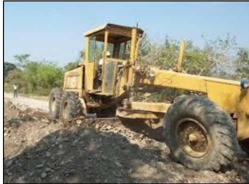
Figura VI.22 Ejemplo del retiro del suelo del área del proyecto para ser confinado y reutilizado en la conformación de los taludes del camino.
