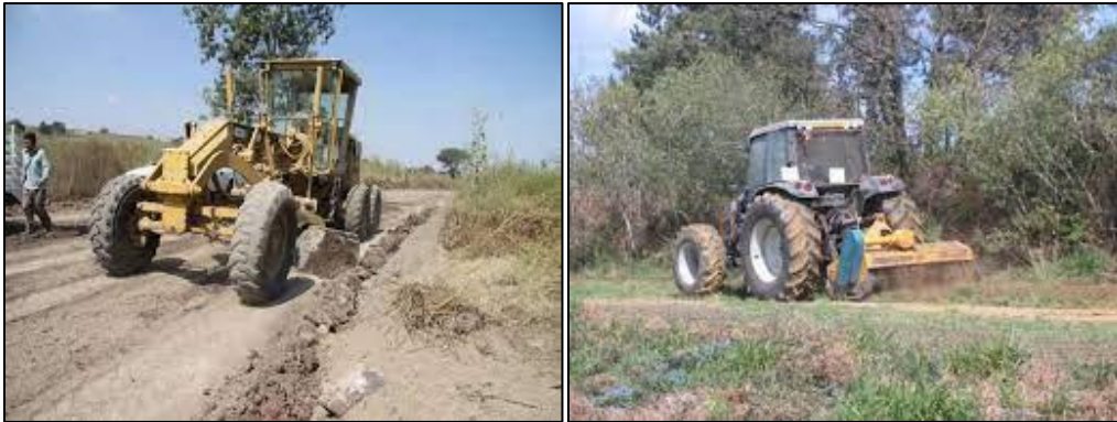
Figura V.1 Ejemplos de la limpieza y despalme del sitio del proyecto.
