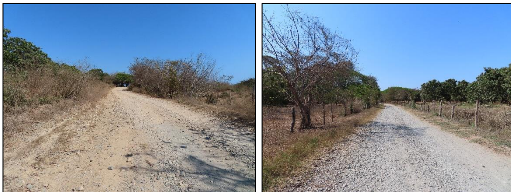
Figura II.1 Condiciones actuales del camino que pretende modernizarse.
