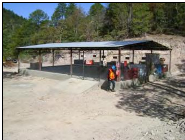
Figura VI.31 Almacén de residuos sólidos en una obra similar.
