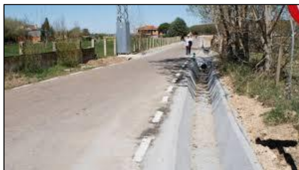
Figura V.12 Ejemplo de una obra de drenaje menor.
