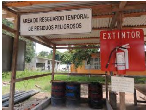
Figura VI.30 Ejemplo de un sitio de resguardo de material peligroso en obras similares.
