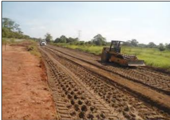
Figura VI.21 Ejemplo de las actividades de construcción de taludes en obras similares.
