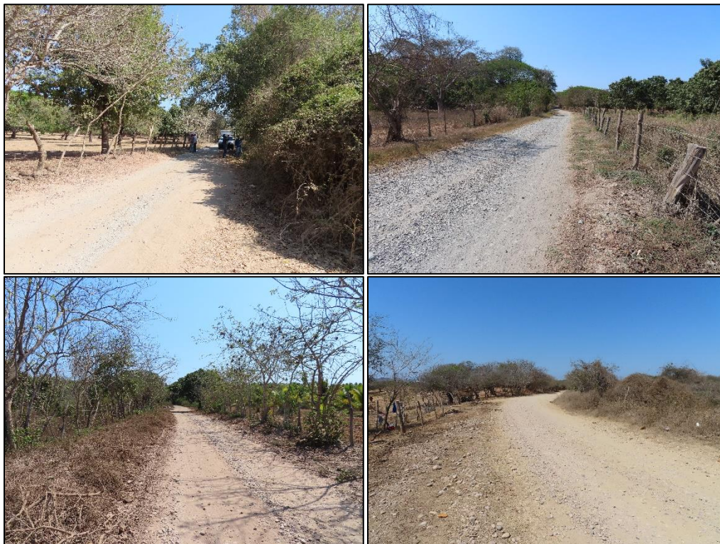
Figura I.1 Vista de las condiciones actuales del camino que pretende modernizarse.
