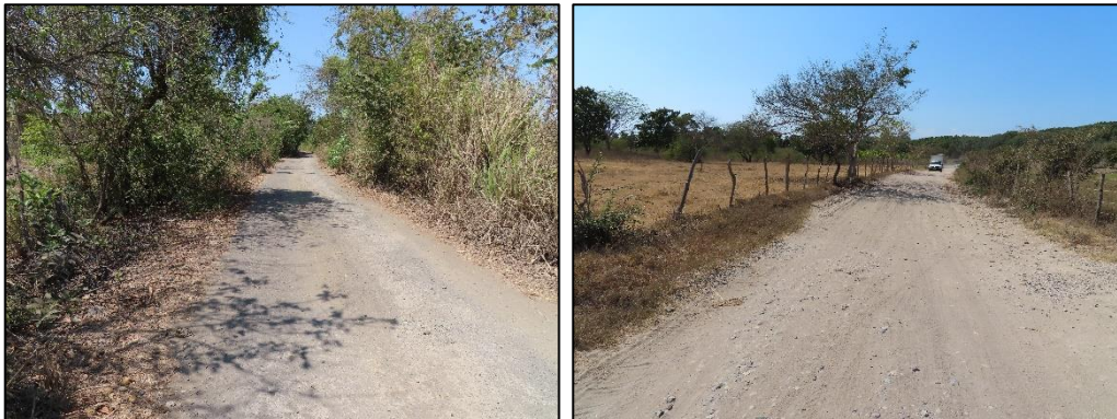
Figura II.25 Vista del camino existente y el cual será utilizado para llegar al frente de obra.
