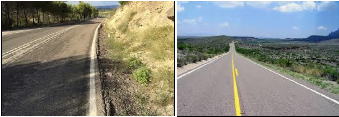
Figura VII.8 Ejemplo de carreteras tipo D en operación.
