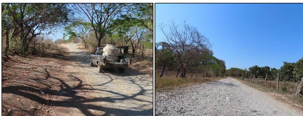
Figura I.4 Condiciones actuales del camino a modernizar.
