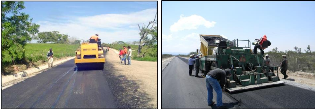
Figura II.29 Ejemplo del encarpado asfáltico de un proyecto similar.
