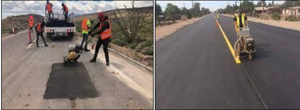
Figura V.3 Actividades de mantenimiento correctivo.
