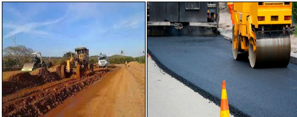
Figura V.2 Terminado de terracerías y pavimentación de un camino similar.
