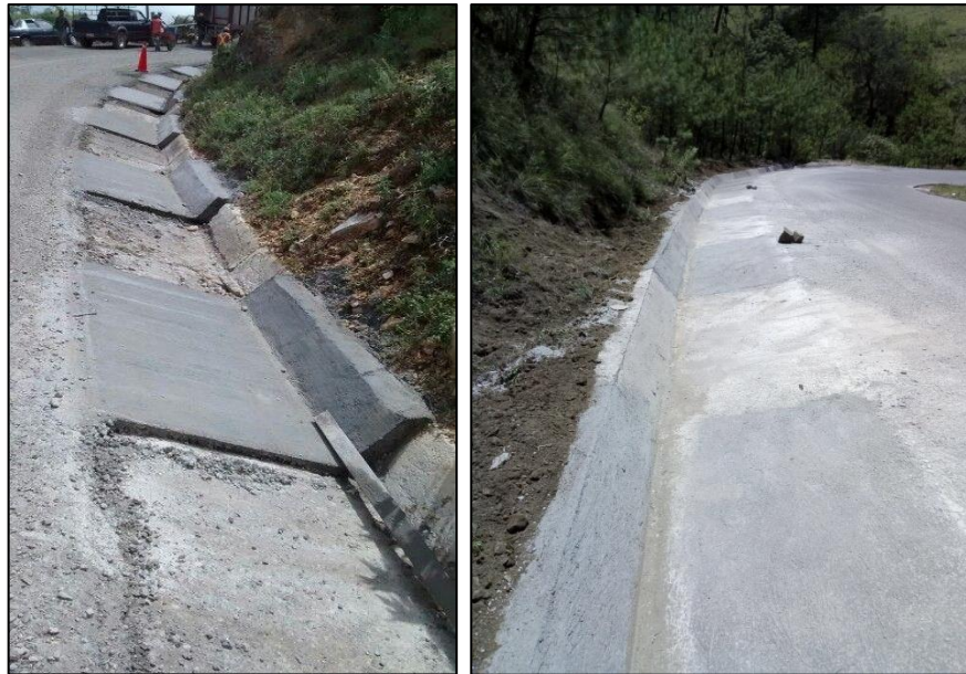
Figura V.10 Ejemplo de construcción de obras de drenaje menor (cunetas).
