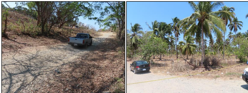
Figura VII.1 Vista de las condiciones actuales del camino a consecuencia del constante uso.
