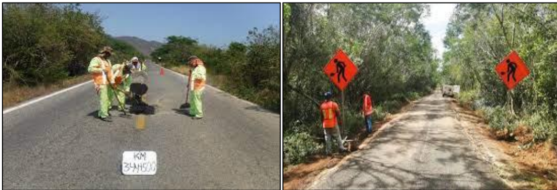
Figura V.18 Ejemplo de obras de mantenimiento en carreteras.
