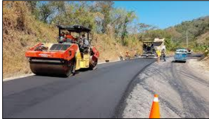
Figura V.11 Ejemplo de una carretera tipo D con la calzada pavimentada.
