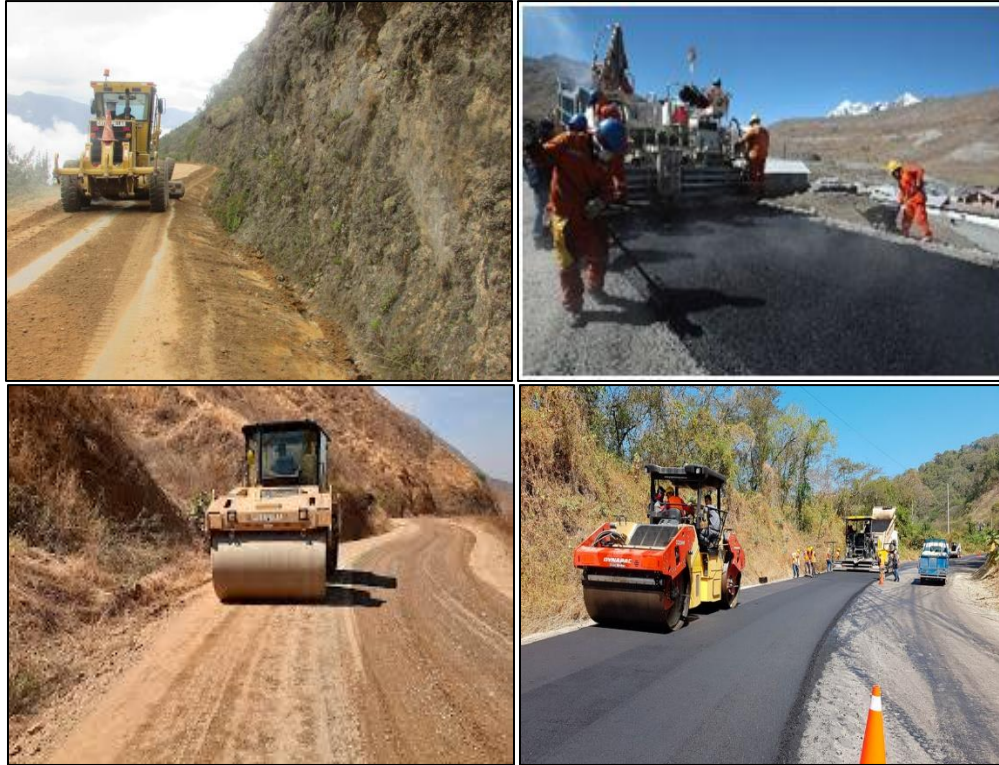
Figura II.34 Ejemplo de la construcción de un camino tipo D.
