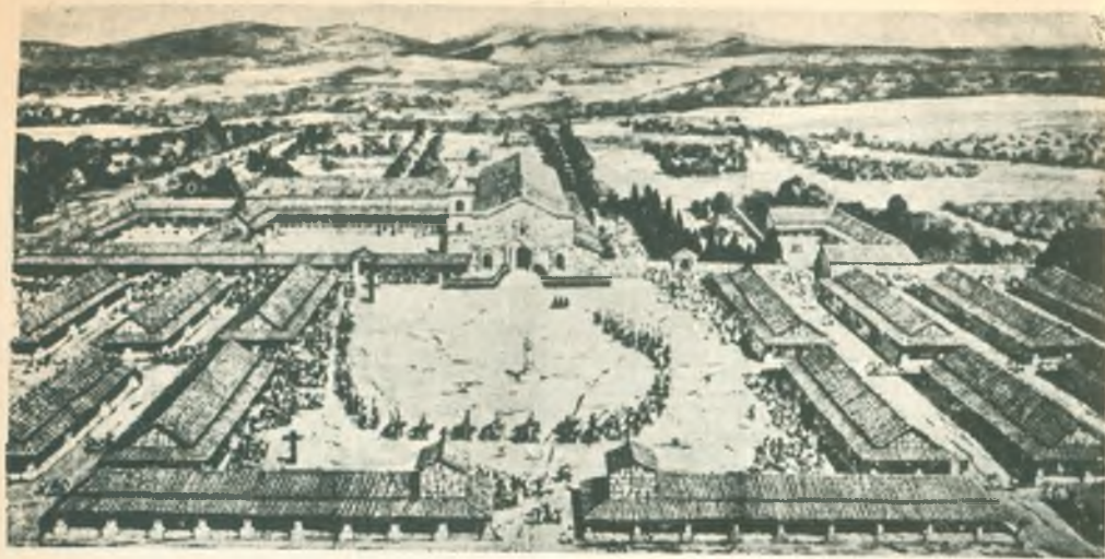
La misión de San Ignacio Mini, según un cuadro de Léonie Matthis. Observe frente a la plaza el edificio de la iglesia, que media 63 metros de largo por 30 metros de ancho y constaba de tres navés con muros de piedra —unida con barro arenoso— reforzados con pilares de madera de lapacho.
