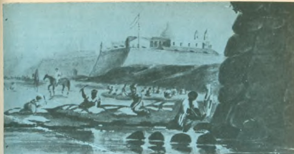
La pintura —obra de Essex Vidal— reproduce una escena típica del Buenos Aires de antaño. En las proximidades del Fuerte (donde actualmente se levanta la Casa de Gobierno) varias negras lavanderas se dedican a su trabajo. Toda la zona ribereña era un lugar de aspecto desagradable, cubierto de lodo y suciedad.
