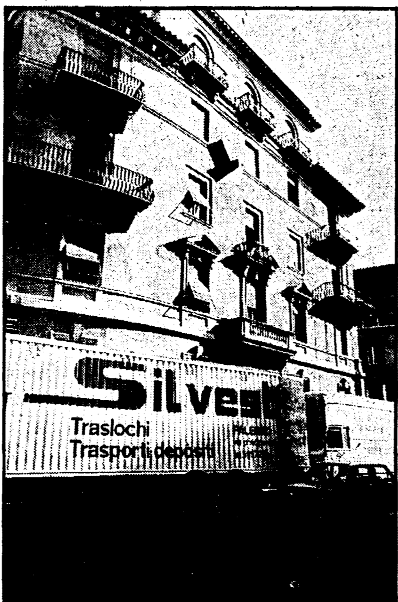
L'appartamento dove è divampato l'incendio
