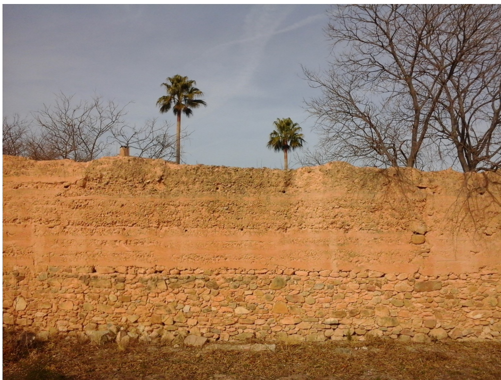
Los Callejones : detalle de un paramento realizado con una base de piedra y mortero y el resto de tapial valenciano. Foto: César Salvo.
