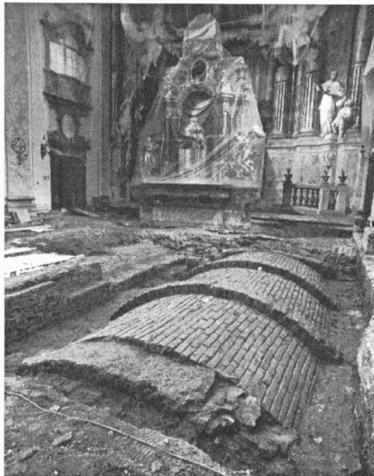
Obr. 4: Valená klenba západního křídla krypty; vlevo klenby chodby a komory.
