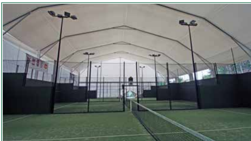
Club de Tennis de A Coruña - pista de pádel interiores
