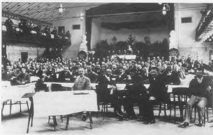
Das 1902 eröffnete Arbeiterheim Favoriten im 10. Wiener Gemeindebezirk wurde zum Vorbild aller folgenden Arbeiterheimprojekte. - Gewerkschaftskongreß 1903. (Abb. 1)
