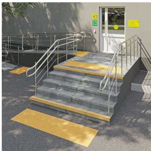
Рисунок 7 – Пример грамотной установки тактильной плитки
