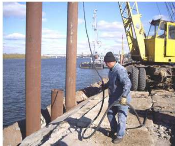
Рисунок 8 – Погружение вибровдавливанием металлических оболочек (труба \text{Ø}630 , l = 13\,400 мм) при берегоукреплении и благоустройстве Центральной набережной р. Волги
