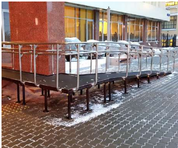
Рисунок 6 – Пример эргономичного устройства пандуса
