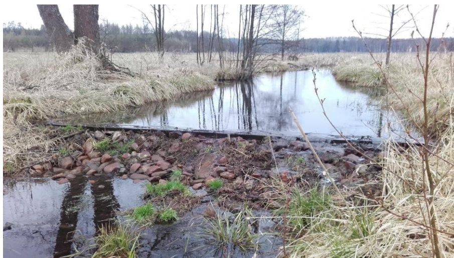
Zastawka piętrząca poziom wody w rowie odwadniającej na mazurskim torfowisku na terenie Nadleśnictwa Maskulińskie. Fot. W. Kotowski.
