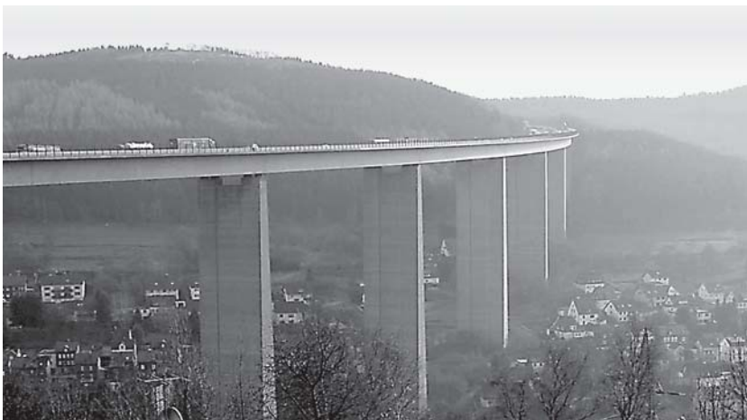
Bild 1: Dichte Bebauung unterhalb einer Talbrücke
