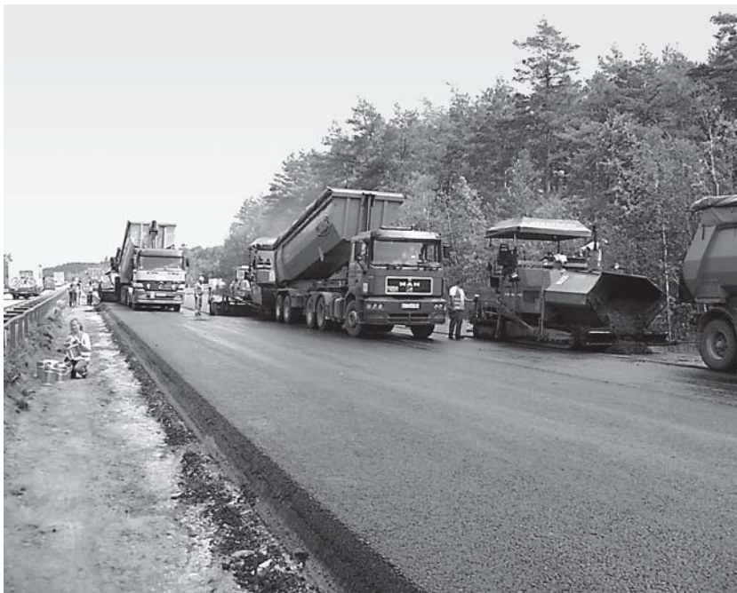
Einbau lärmarmer Splittmastixasphalt (BAB A93 bei Schwandorf)
