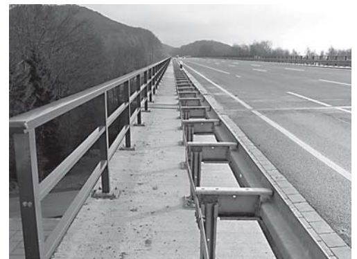
Bild 2: Ausführung einer Einfachen Distanzschutzplanke mit Geländer
