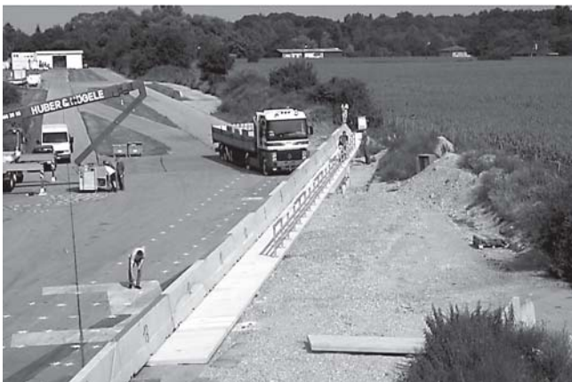
Bild 3: Übersicht Testgelände der TÜV Automotive GmbH, München, mit nachgebauter deutscher Brückenkappe und Lkw am Anprallpunkt
