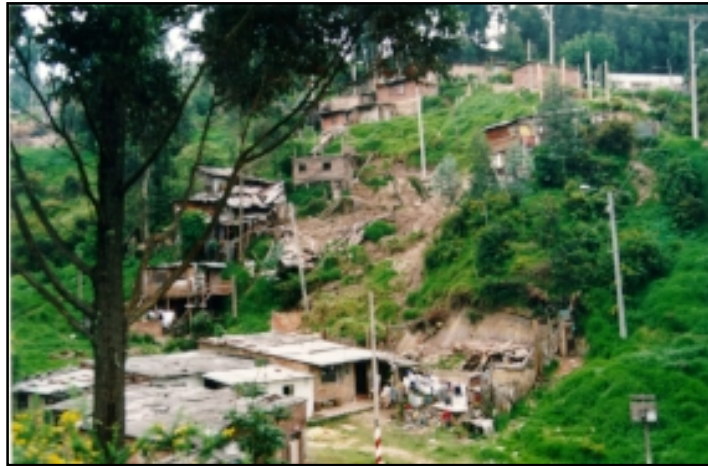
Fotografía 3.8. Unidad geomorfológica conformada por laderas de depósitos coluviales intermedios, localizado en el sector suroriental del barrio Triángulo, se presentan deslizamientos activos que han afectado varias viviendas.
