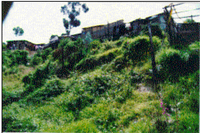
Fotografía 3.3. Depósito coluvial reciente localizado en el costado sur del Barrio Triángulo Alto, es frecuente la presencia de procesos de remoción en masa activos.
