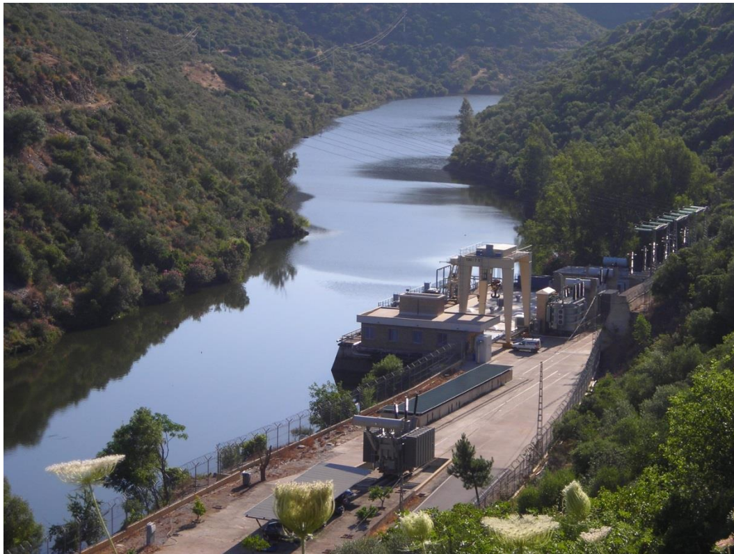
Fig. 38. Vista de la central eléctrica de Guillena sobre el río Rivera de Huelva.
