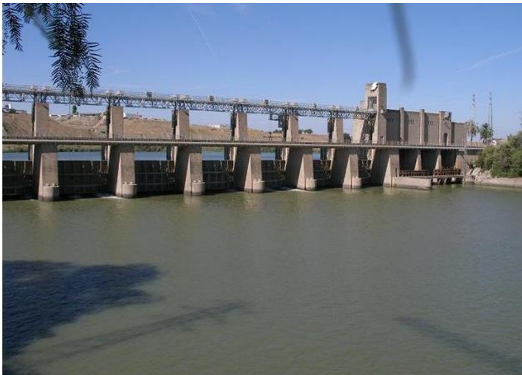
Fig. 54. Imagen de la Central hidroeléctrica de Alcalá del Río, en Sevilla.
