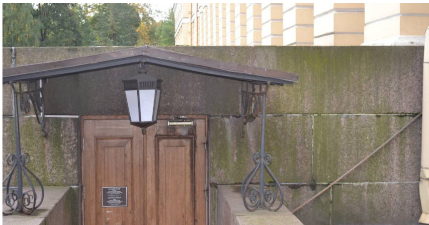
Рис. 3. Развитие биопленки с доминированием зеленых водорослей на граните в городской среде. Санкт-Петербург. Михайловский сад.
