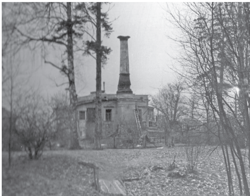
Рис. 5 Здание водопадающей машины. Фото 1970-е гг.
