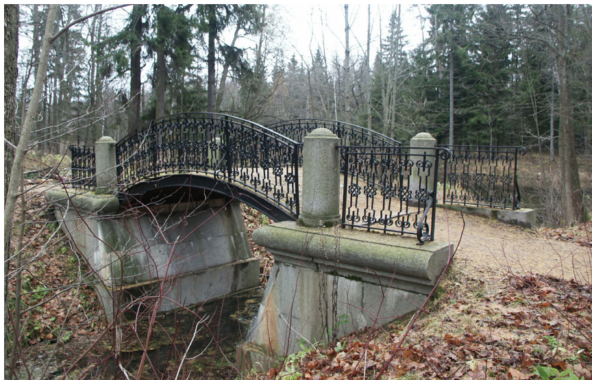
Рис. 9 Восстановленный гранитный мостик протоки западного ручья. Фото 2006 г.
