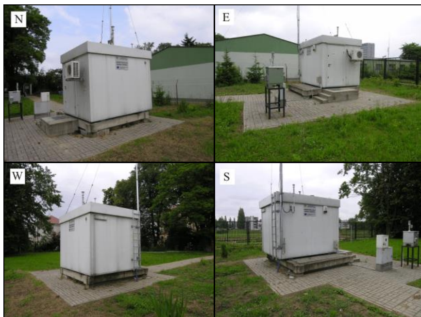
Rysunek 4 Otoczenie stanowiska pomiaru pyłu zawieszono PM10 i PM 2,5 przy ul. Szopena w Rzeszowie
