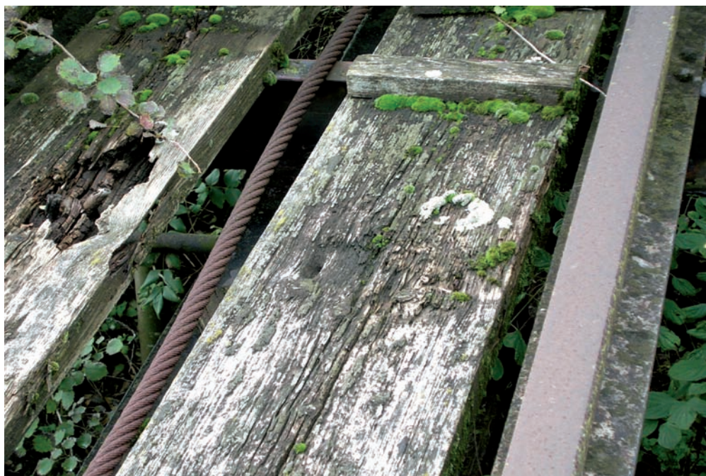
Abb. 7: Verbautes Holz und Eisen mit reichem Flechtenbewuchs im oberen Bereich der südlichen Halde.
