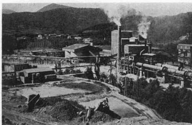
FIG. 3.—Hornos rotativos utilizados en la calcinación de la magnesita.
