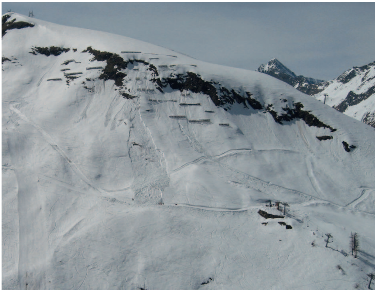
■ Champorcher: vista aerea del pendio da cui il 1 aprile si distacca la massa nevosa. Sono visibili i numerosi ponti da neve e la porzione terminale dell'impianto di risalita denominato Laris.
