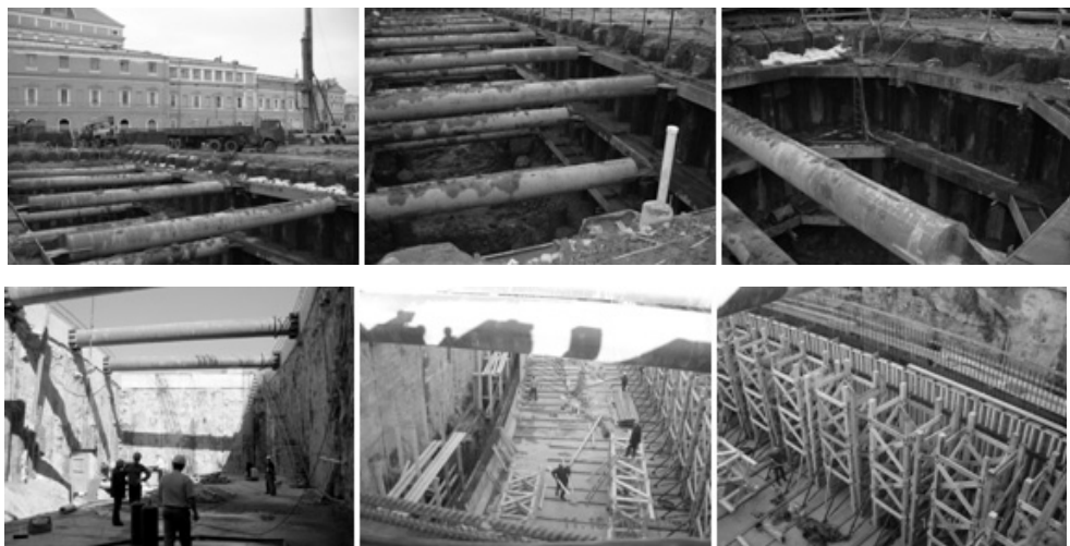
Рис. 3.7. "Стена в грунте", на острове Новая Голландия
