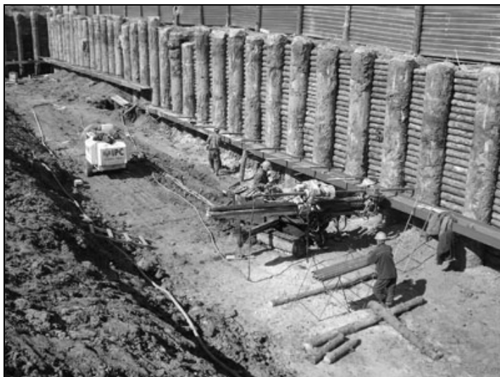
Рис. 4.3. Устройство грунтовых анкеров
