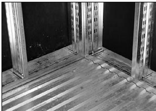
Рис. 5.5. Несущий настил перекрытия
