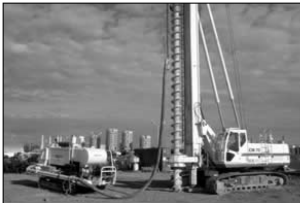
Рис. 3.4. Погружение армокаркаса производится при помощи буровой установки
