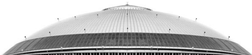
Рис. 6.20. Система измерения высоты снежного покрова
