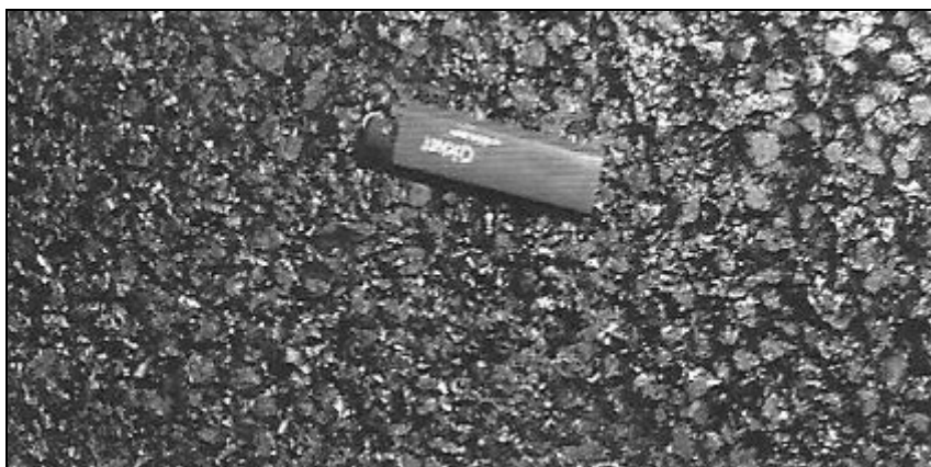
Рис. 2.4. Асфальтобетонное покрытие методом высокотемпературной запрессовки
