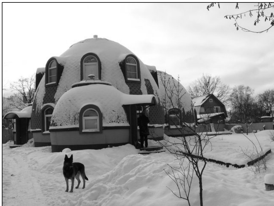
Рис. 6.12. Экодом в Заполярье
