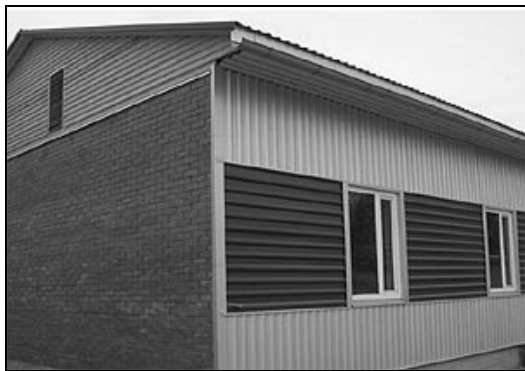
Рис. 5.3. Наружная облицовка здания
