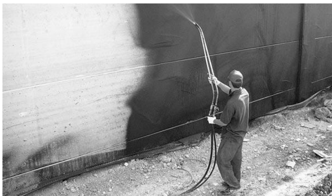
Рис. 1.7. Насыление жидкой резины
