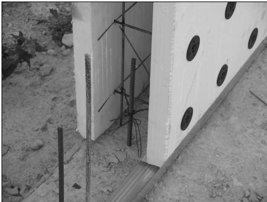
Рис. 7.24. Конструктивные элементы системы PLASTBAU:
