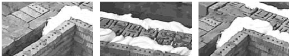
Рис. 1.6. Использование заливочного пенопласта
