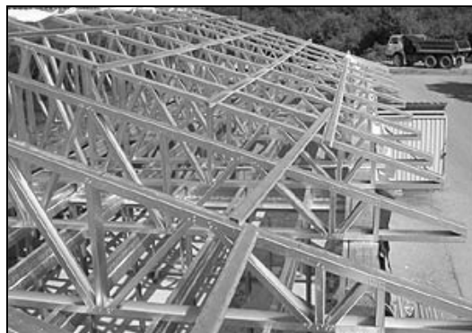
Рис. 5.6. Стальные фермы покрытия
