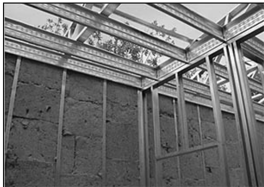
Рис. 5.2. Утепление наружных стен
