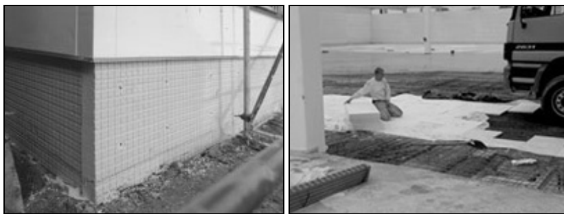
Рис. 4.8. Фундаменты на грунтовой подушке
