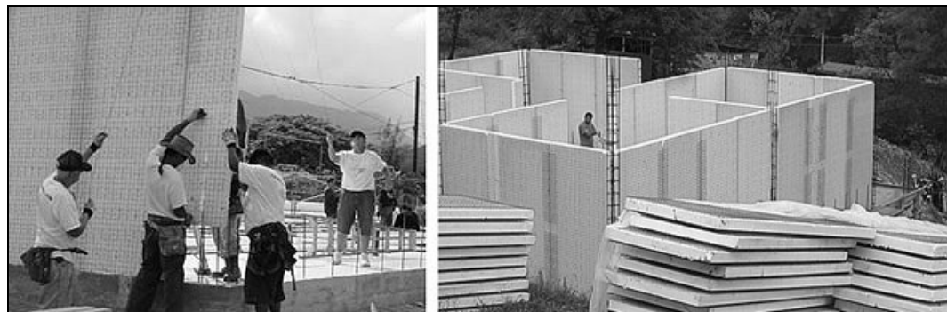
Рис. 7.35. Новая строительная система СОТА
