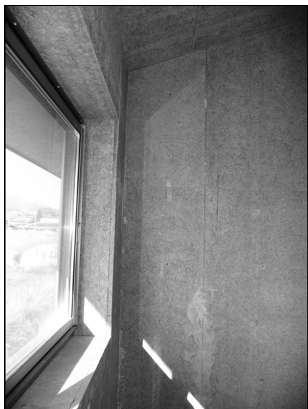
Рис. 7.1. Применение плит Eltomation
