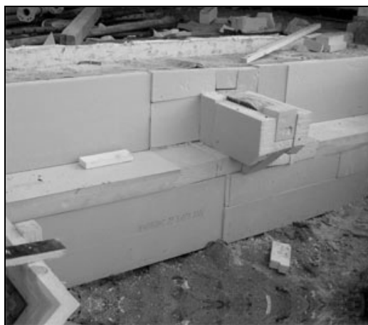
Рис. 4.23. Утепление фундамента экструдированным пенополистиролом и утепление полов первого этажа
