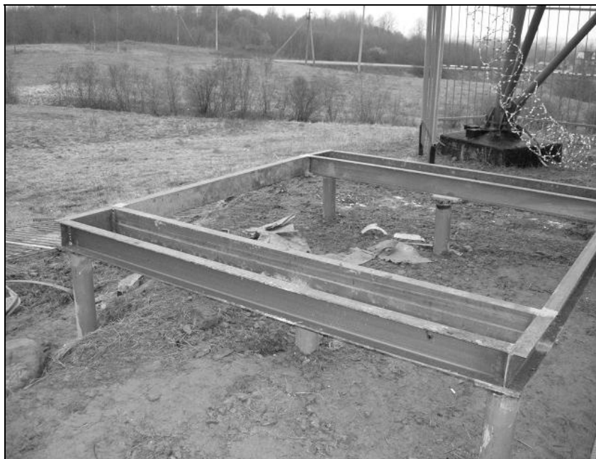
Рис. 7.15. Фундамент для канадского дома устанавливается на винтовых сваях
