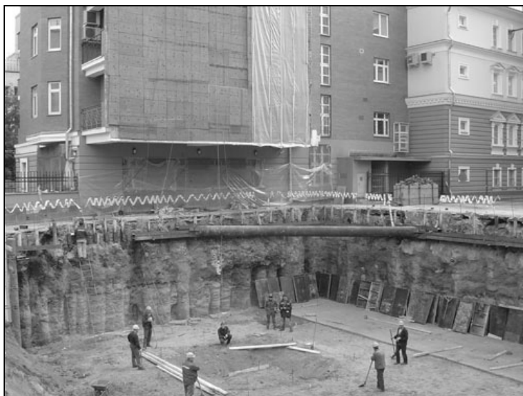
Рис. 4.4. Крепление бортов котлована
