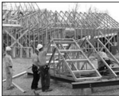
Рис. 5.1. Металлокаркас, состоящий из легких стальных тонкостенных конструкций
