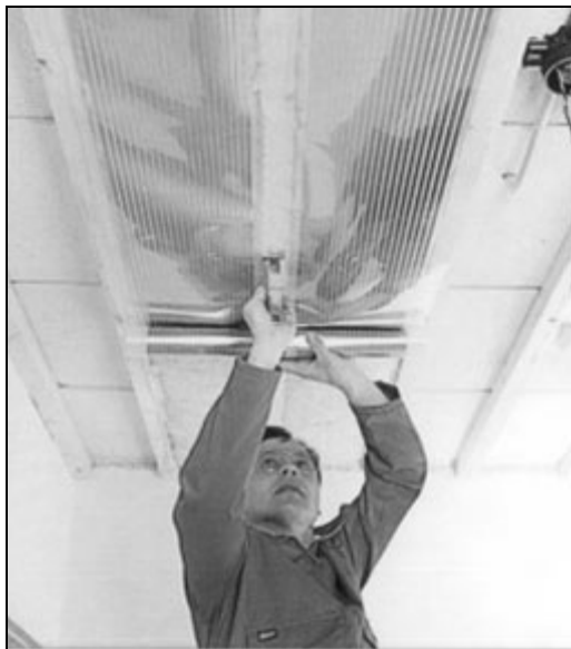
Рис. 6.29. Монтаж греющей фольги Alson
