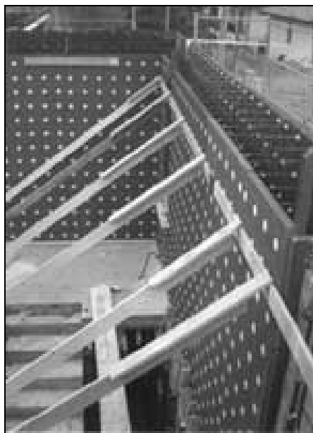
Рис. 7.50. Опалубка несущих и внутренних стен Dobeles panelis
