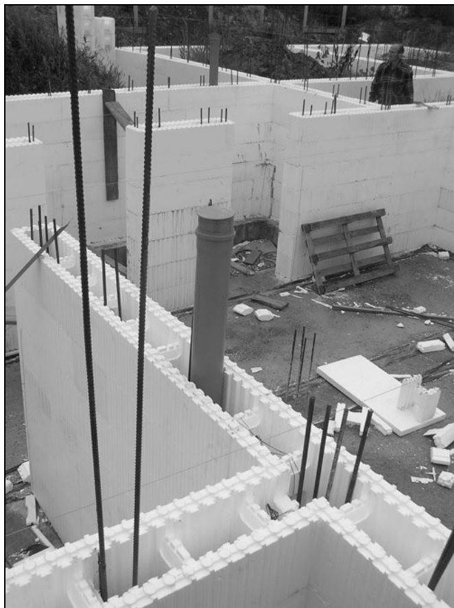
Рис. 7.32. Технология Теплый дом
