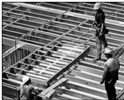
Рис. 5.1. Металлокаркас, состоящий из легких стальных тонкостенных конструкций
