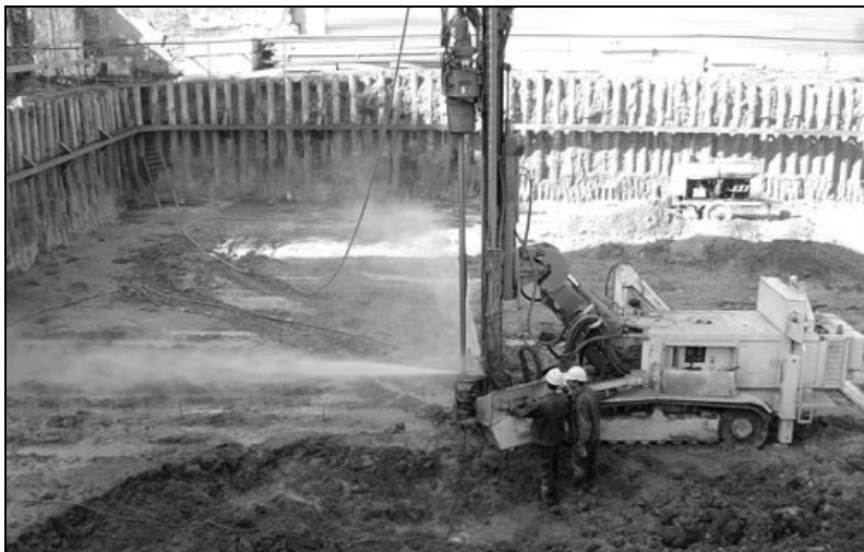
Рис. 4.5. Крепление дна котлована
