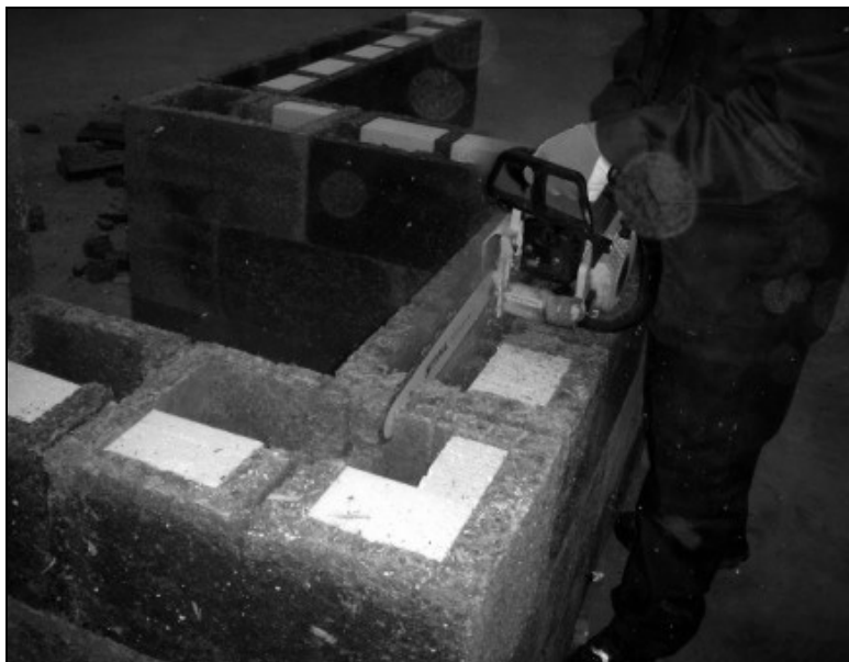
Рис. 7.9. Технология строительства с применением блоков Durisol
