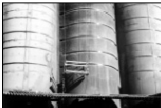
Рис. 4.17. Усиление цементных силосов ЖБК
