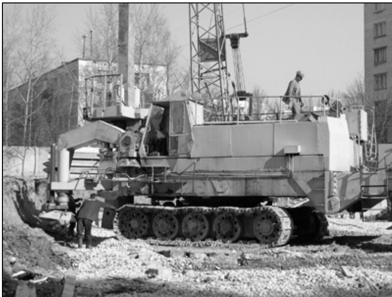
Рис. 3.16. Способ устройства инъекционной сваи
