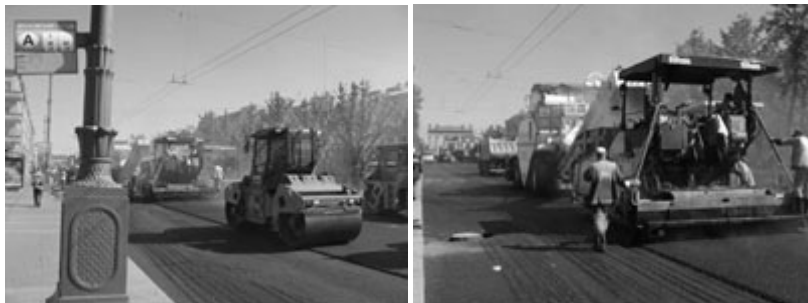
Рис. 2.1. Устройство дорог из нового щебеночно-мастичного асфальтобетона
