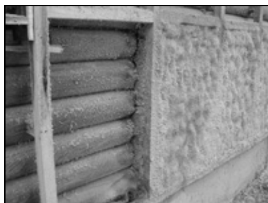
Рис. 7.20. Пример напыления эковаты
