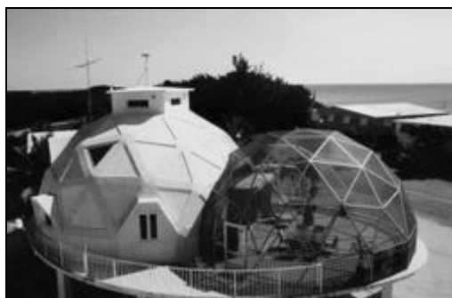
Рис. 6.10. Использование нанотехнологий позволит строить дома, которые смогут простоять 300—400 лет
