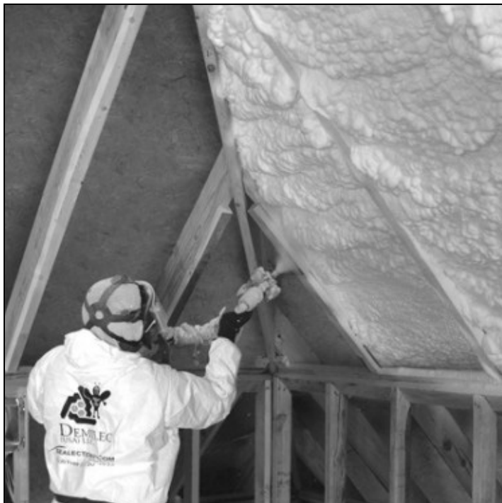
Рис. 4.24. Использование пенного утеплителя
