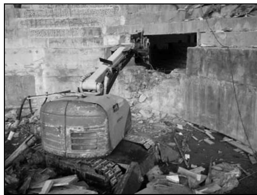
Рис. 8.7. Алмазное пиление (а) и смешанный способ демонтажа с применением роботов Brokk (б)
