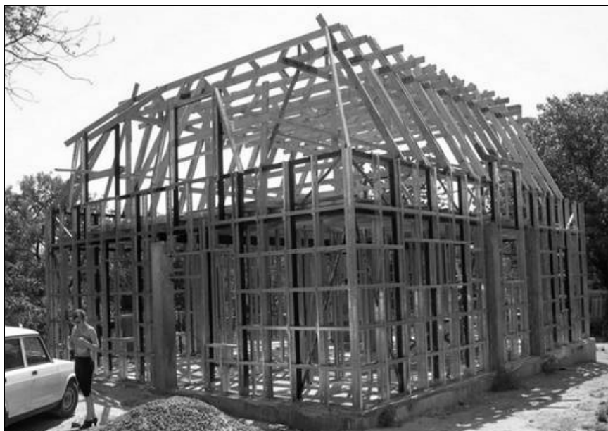
Рис. 7.18. Строительная система Термокаркас
