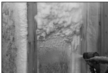
Рис. 7.21. Утепление деревянных конструкций
