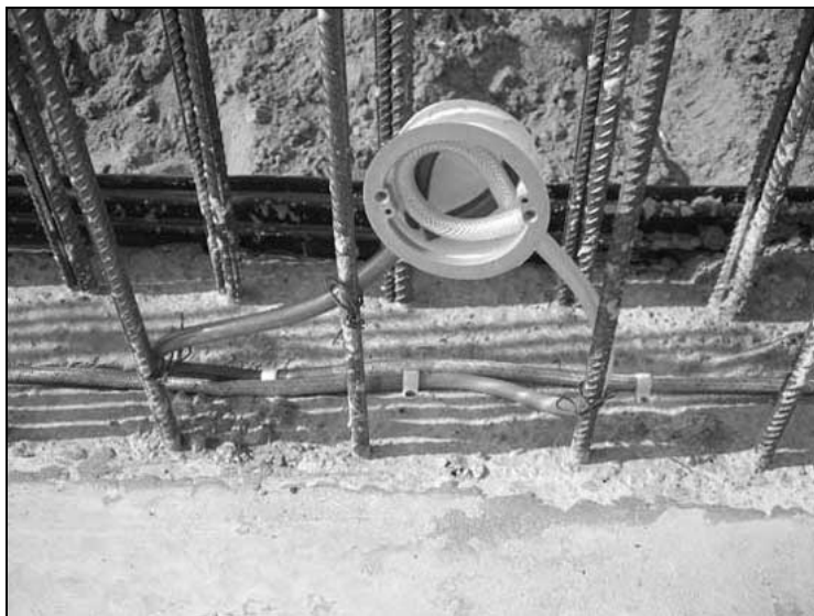
Рис. 4.14. Уникальный инженерный рукав
