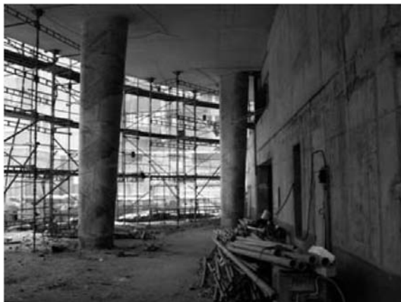
Рис. 4.19. Усиленная колонна круглого сечения
