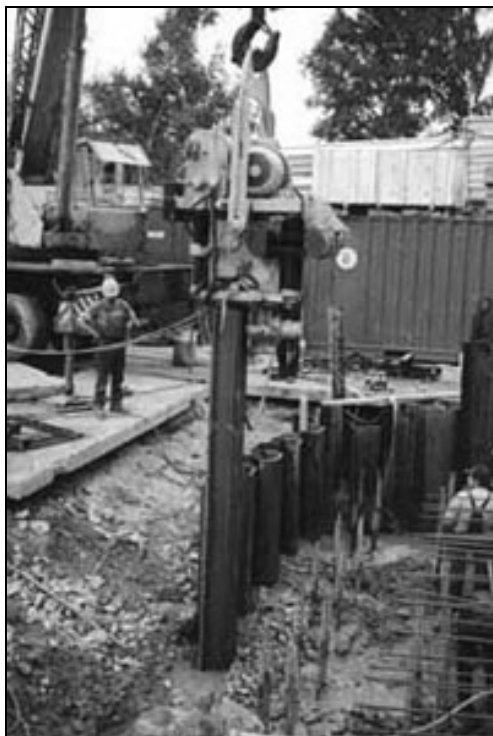
Рис. 3.1. Шпунтовое ограждение
