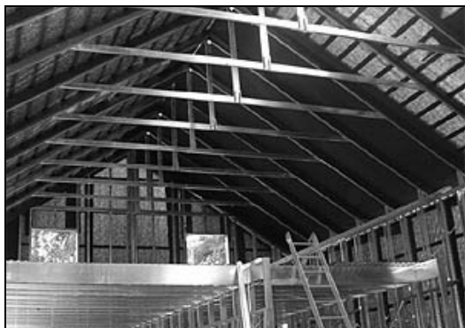
Рис. 5.7. Стальные балки перекрытия
