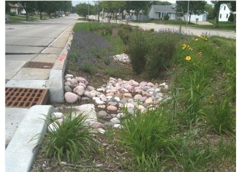
Figura 4: pietrame posto a protezione dell'ingresso delle acque in un canale inerbito
