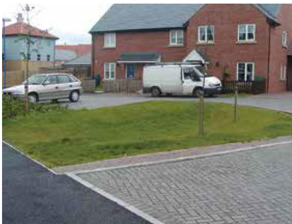
Figura 3: bacino di infiltrazione con elemento di scarico per il troppo pieno (GreenTreks Network, Inc.); planimetria di un bacino con definizione dei principali elementi costitutivi e bacino di piccole dimensioni in area urbana.
