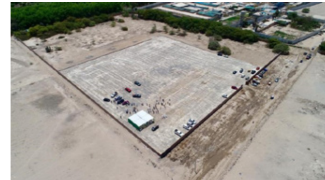
FIGURA 2: INICIO DE LOS TRABAJOS EN EL MAT ICA 30-12-20
