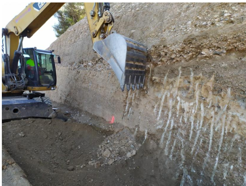
Figura 8. En aquesta fotografia es veu la giratòria Caterpillar realitzant el perfilat de la part més alta a on anirà el calaix de l'escullera. Al damunt de la pala es pot veure un nivell de conglomerats prou potent de gruix.
