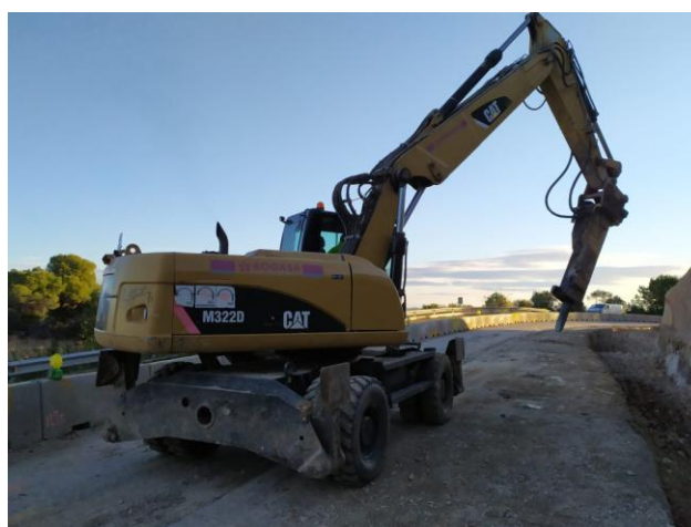
Figura 7. Excavadora giratòria amb rodes Caterpillar model M322D, el Martell percutor hidràulic (pica-pica).
