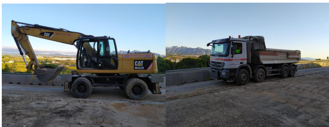
Figura 6. Excavadora giratòria amb rodes Caterpillar model M322D i un dels camions.
