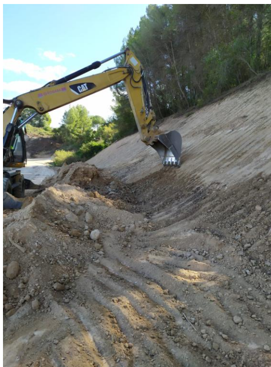
Figura 11. La giratòria Caterpillar acabant de realitzar el talús, en el sector més occidental de les obres.
