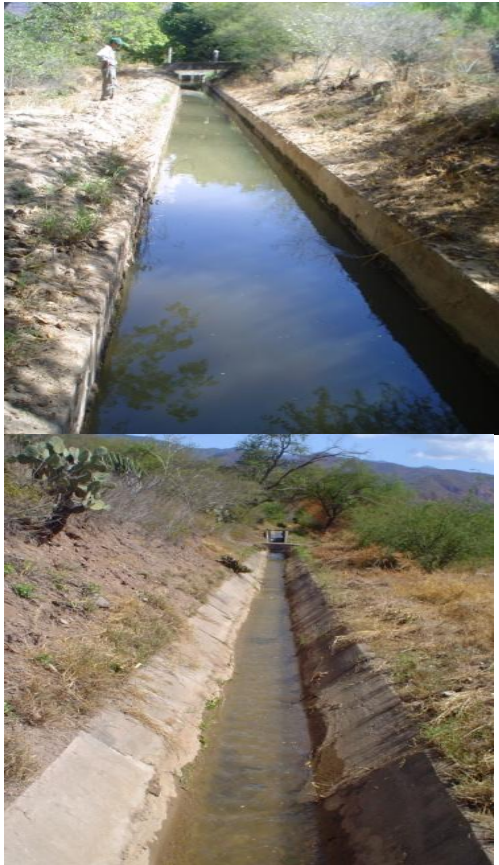
Figura 1.21b Flujo uniforme en canales prismáticos, unidad de riego rural "Matamba", Cuicatlan.
