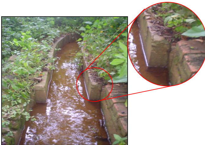
Figura 2.32. Cambio de un régimen a otro al cambiar el ancho el canal.
