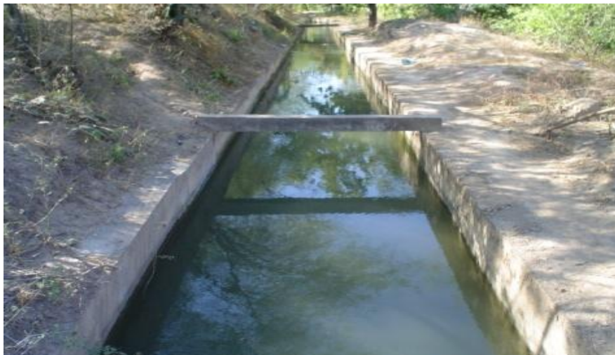
Fig. 1.40 Canal de Sección rectangular revestido de concreto
