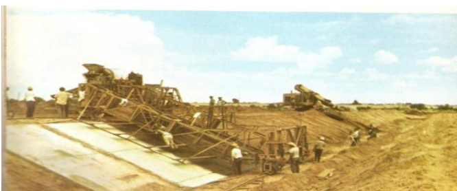
Fig. 1.32 Canales de sección trapezoidal revestidos de concreto hidráulico.
