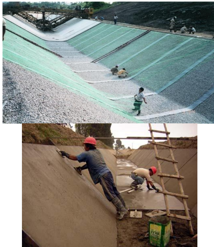
Fig. 1.32 Canales de sección trapezoidal revestidos de concreto hidráulico.
