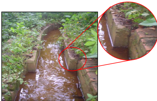
Figura 2.22a'. Contracción brusca en canal lateral de sección rectangular revestido de tabique unidad de riego rural "Santo Domingo Tomaltepec", Oax.
