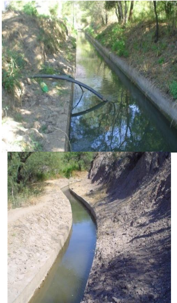
Fig. 1.39 canales de sección rectangular revestidos de concreto
