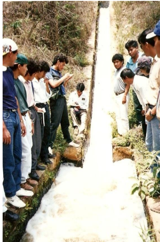
Fig. 3.53 Presencia del Salto hidraulico en rápida con tanque amortiguador rectangular, Canal principal unidad de riego "Huitzo", Oaxaca.
