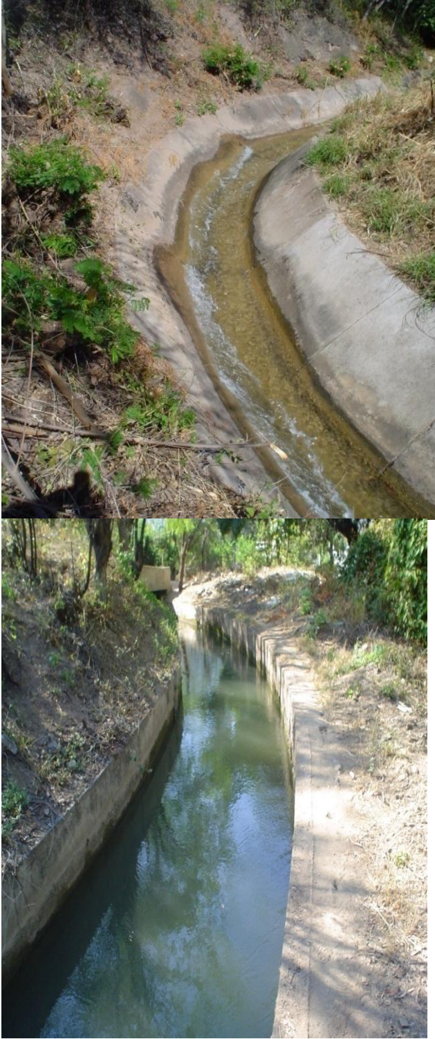
Figura 2.59. Curvas horizontales canal principal revestido de concreto de sección trapecial unidad y sección rectangular unidad de riego rural " Matamba", Cuicatlan.
