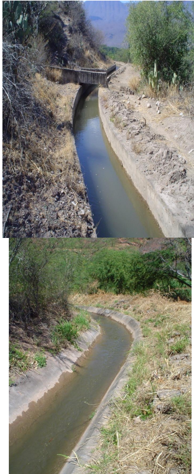
Figura 2.60. Curvas en canal lateral sección rectangular y en canal de sección trapecial revestidos de concreto.
