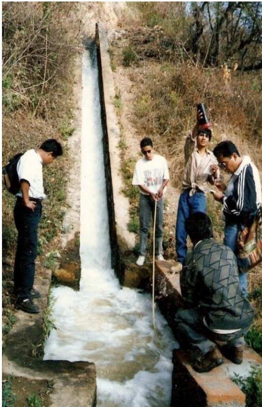
Fig. 3.52 Presencia del Salto hidraulico en rápida con tanque amortiguador rectangular, Canal principal unidad de riego "Huitzo", Oaxaca.
