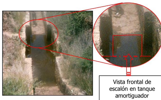
Figura 2.20c. Escalón positivo localizado cerca al pie del salto.
