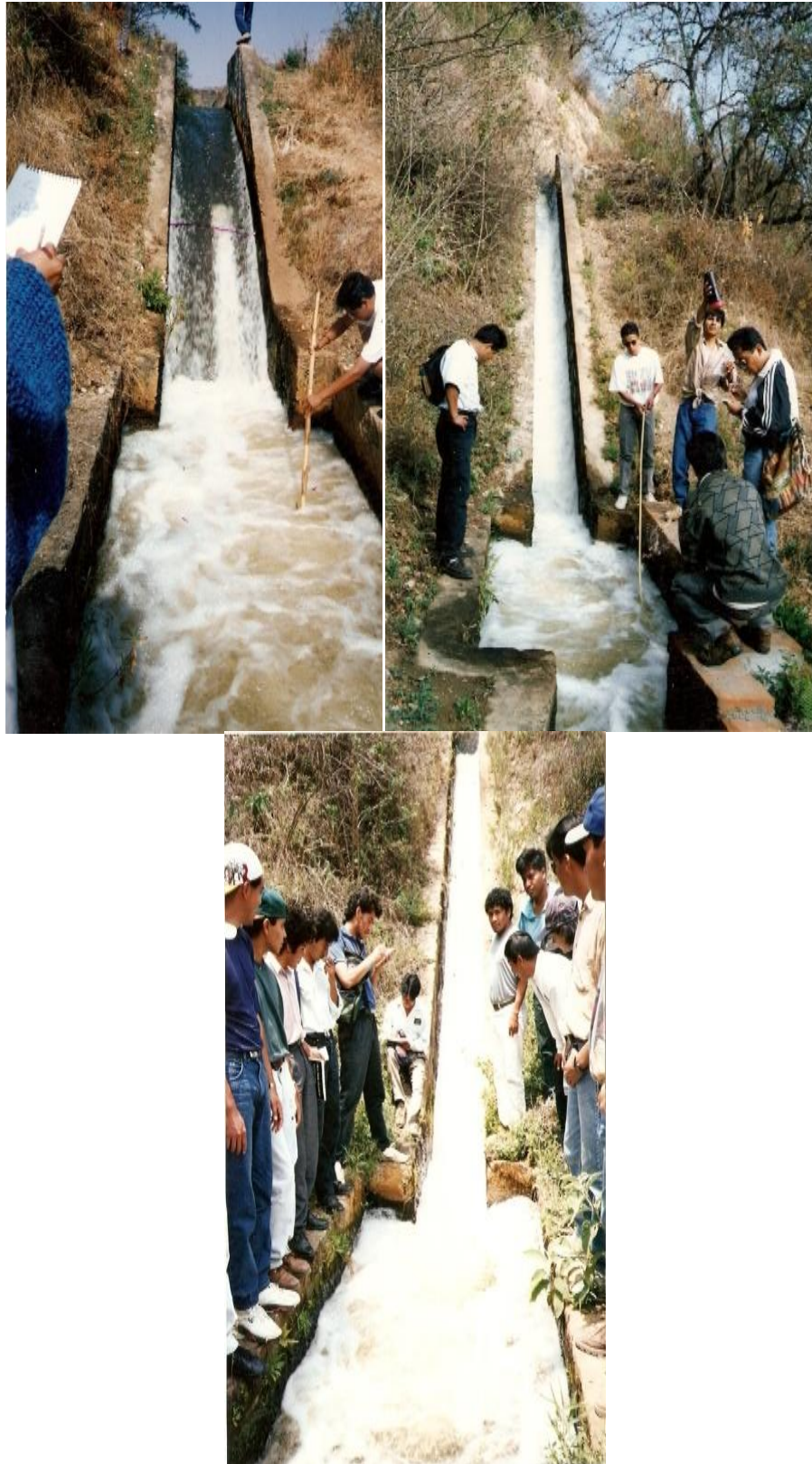
Figura 3.9. Formación del salto hidráulico en estructuras de canales.
