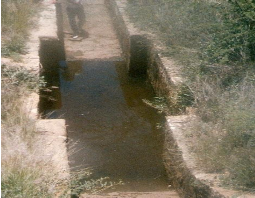
Figura 3.41 Tanque amortiguador rectangular en caída vertical.
