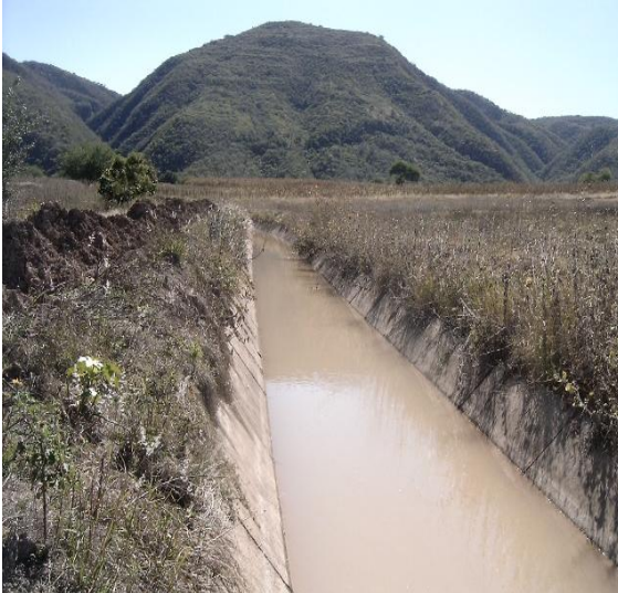
Fig. 1.36. Canales de sección trapecial revestidos de concreto.
