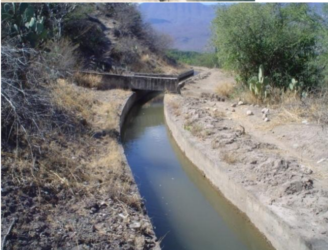
Figura 1.21. Presencia de flujo uniforme, canal principal "unidad riego Ixtepec". Oax.
