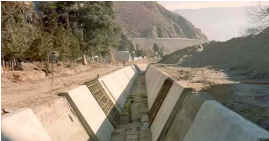
Fig. 1.4a canal artificial de Secciones transversales trapecial.
