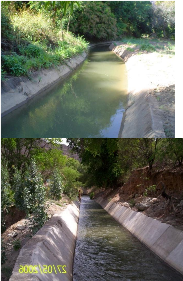
Fig. 1.38 canales revestido de concreto de sección trapecial.
