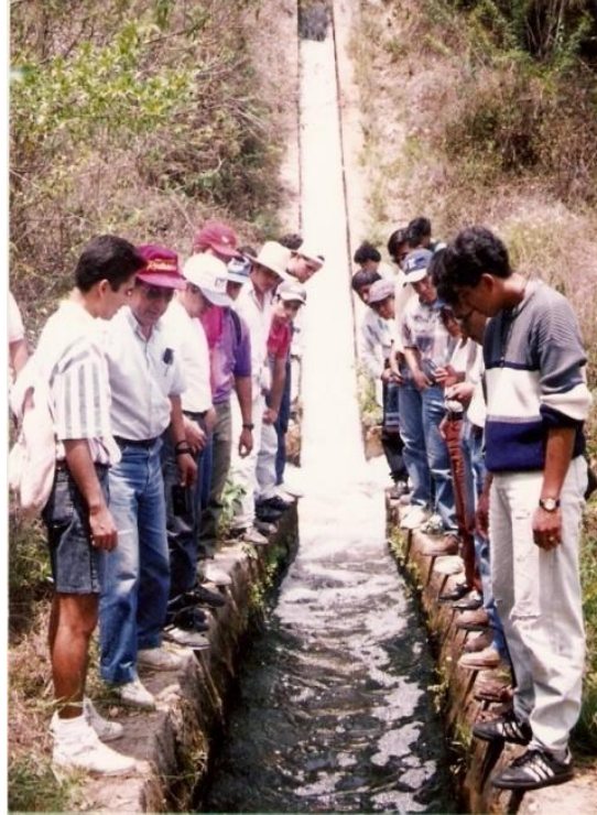
Figura 3.54. Salto hidráulico en rápida, se observa la sección tanque amortiguador rectangular.
