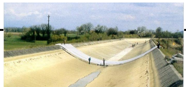
Fig. 1.32 Canales de sección trapezoidal revestidos de concreto hidráulico.
