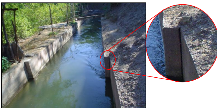
Figura 2.33b. Cambio de sección de plantilla en canal principal de sección rectangular unidad de riego rural "Matamba", Cuicatlan.
