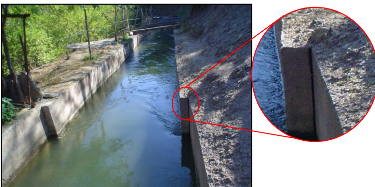
Figura 2.22a'. Contracción brusca en canal lateral de sección rectangular revestido de tabique unidad de riego rural "Santo Domingo Tomaltepec", Oax.
