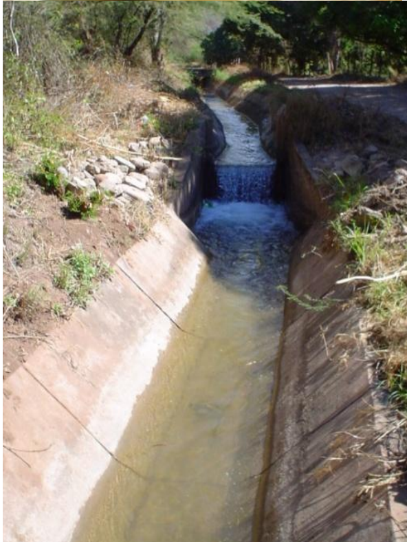
Figura 3.39. Caída inclinada con tanque
