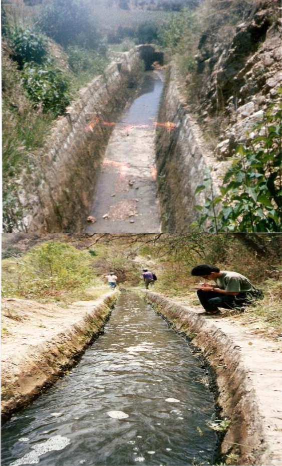
Fig. 1.37 Canal revestido de mampostería de sección trapecial.
