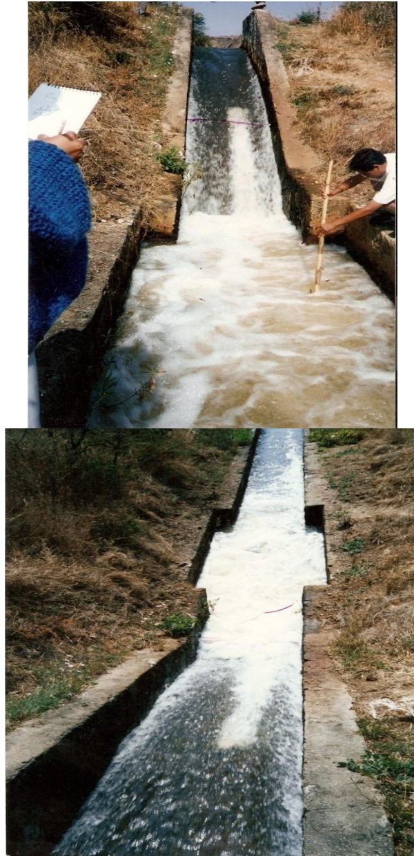
Figura 3.43 Rápida con tanque amortiguador rectangular se observa la formación del salto hidráulico.
