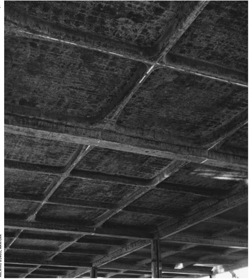
intradosso del solaio a nervature del magazzino della carta / intrados of the ribbed roofing of the paper warehouse
