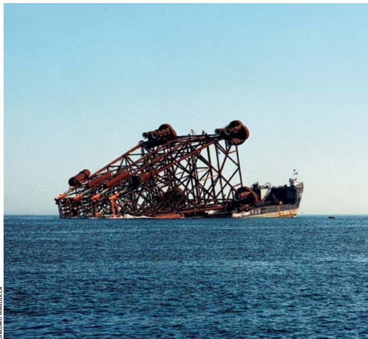
due momenti del varo del jacket / the launching of the jacket
