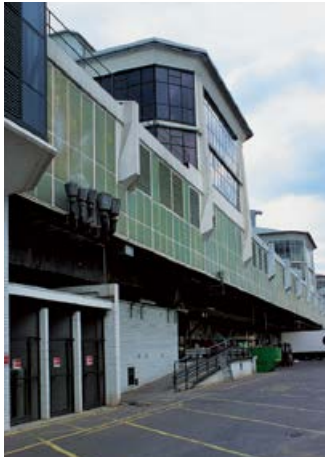
banchina per lo scarico, prospetto sud, 1997 / unloading docks, south front, 1997
