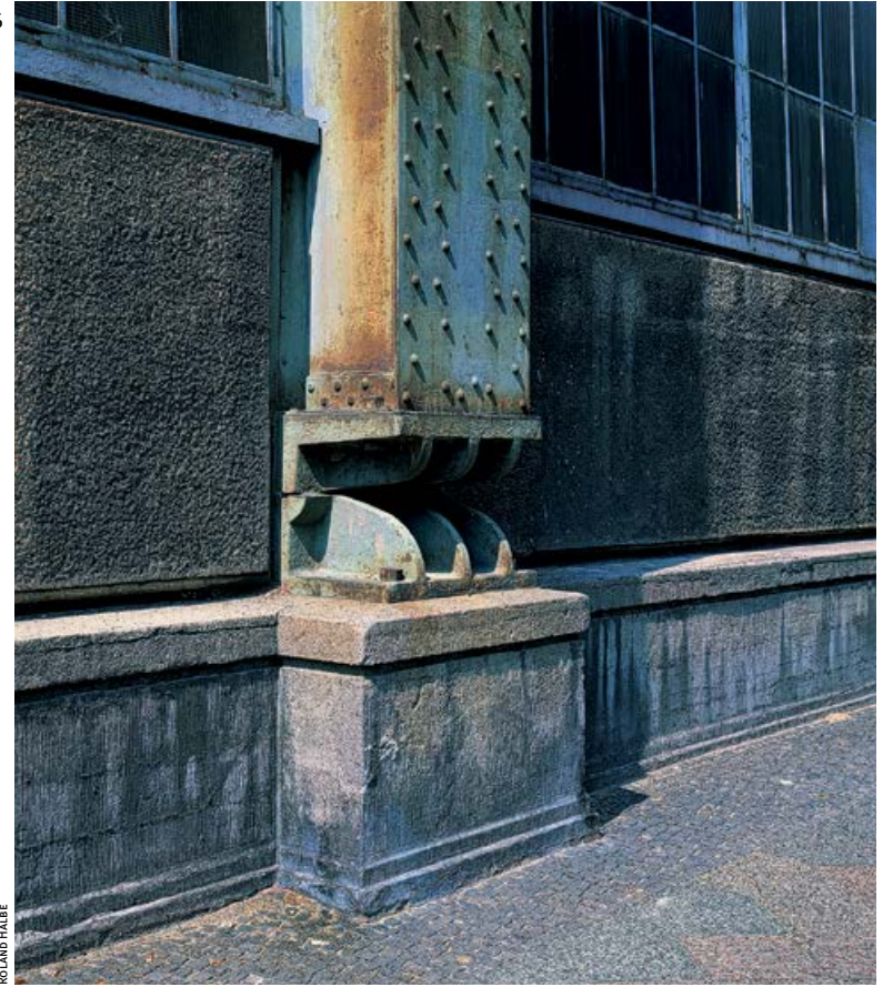
dettaglio dei pilastri poggianti su cerniere / detail of the pilasters set onto joints
