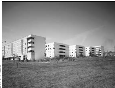
complesso residenziale a Mendillorri, Navarra, 1993-95, con Alfonso Alzugaray Los Arcos veduta generale / overall view
