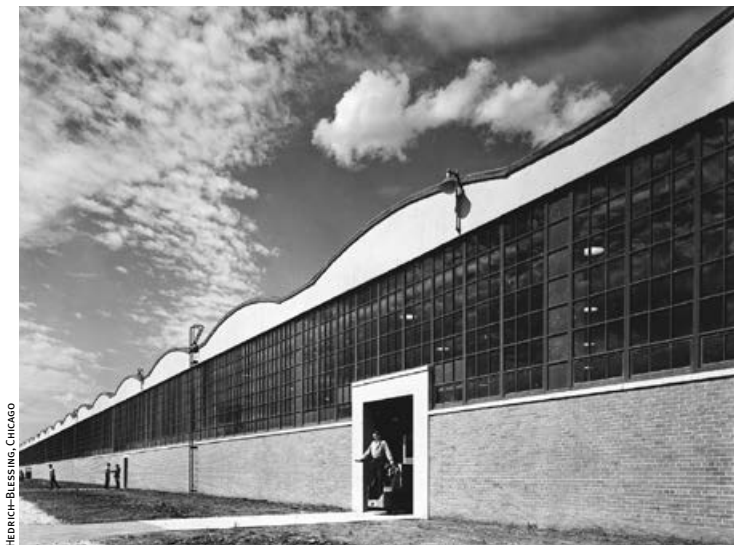
Chrysler Corporation, Wright Engine Plant, Machine Shop, Chicago (Illinois) giugno 1942 – settembre 1943
