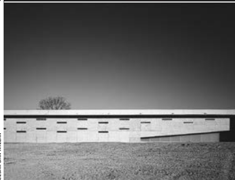
complesso scolastico a Mendillorri, Navarra, 1996-97, con Alfonso Alzugaray Los Arcos dettaglio di un prospetto / detail of an elevation
