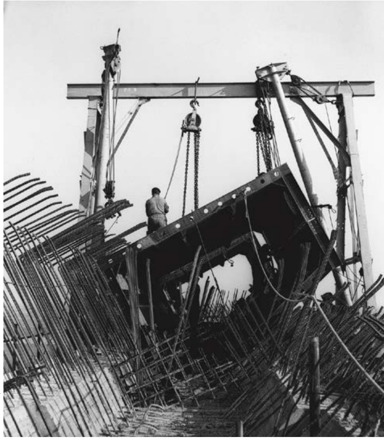
i cassoni metallici inglobati nei getti delle travi cave alla sommità dei cavalletti / the metal caissons contained in the pourings for the hollow beams at the top of the trestles
