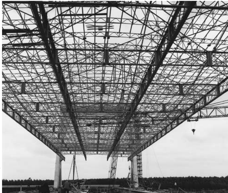
montaggio della griglia di travi reticolari della copertura in via di ultimazione / assembly of the grid of reticular beams of the roofing, near completion
