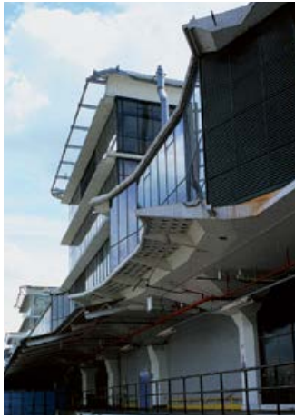
servizi per l'invio delle merci, prospetto nord, 1997 / dispatch bay, north front, 1997
