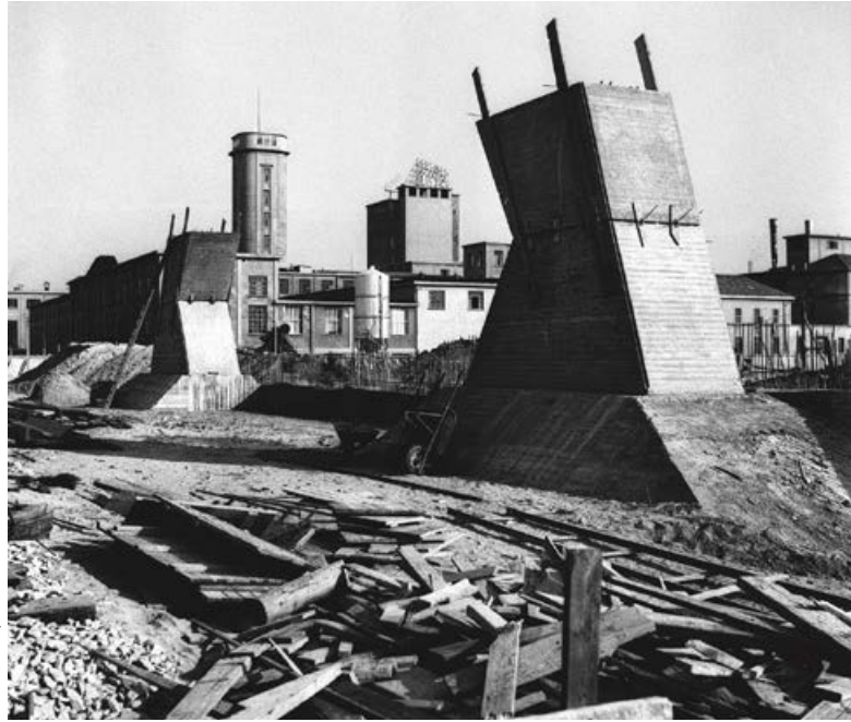
montaggio delle casseforme di uno dei grandi cavalletti / assembly of the box-moulds of one of the large structural trestles
