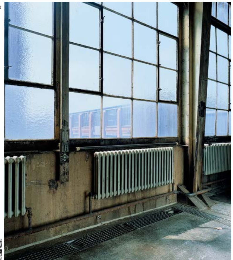
facciata interna con l'alternanza tra montante sospeso della finestra e pilastro / internal facade with the alternation of the suspended upright of the window and the pilaster
