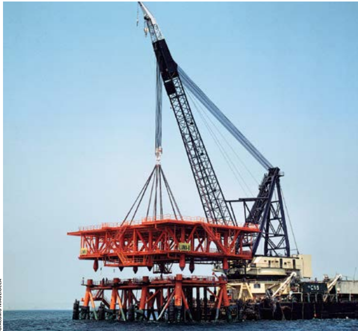
installazione del deck / deck installation
