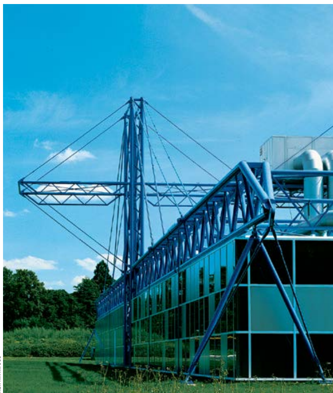
scorcio del prospetto principale con la trave reticolare protesa sull'ingresso / view of the main facade with the reticular beam extending over the entrance
