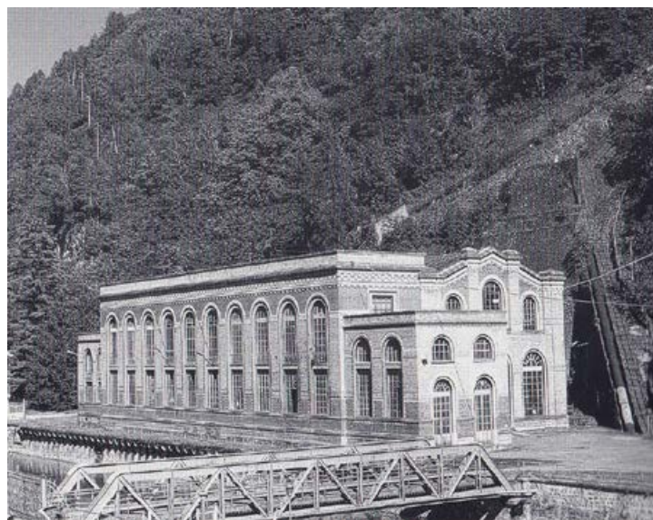
Grosotto, Sondrio, 1908 centrale elettrica / electric power plant
