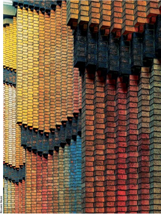
dettaglio della parete in mattoni della hall / detail of the brick wall of the hall
