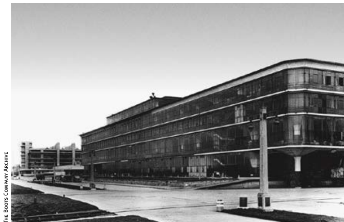
prospetto occidentale con la Drys Factory sullo sfondo / west front, with Drys Factory in the background
