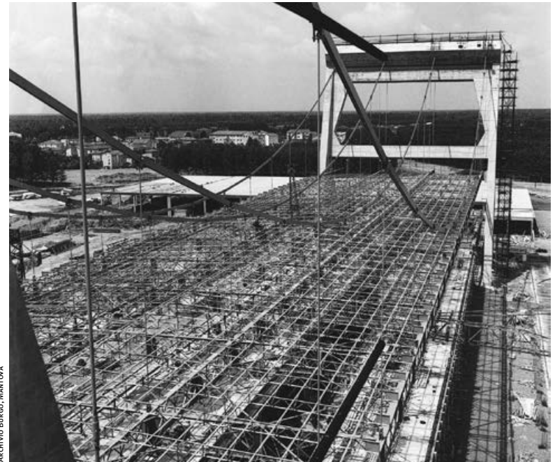
montaggio della griglia di travi reticolari della copertura in via di ultimazione / assembly of the grid of reticular beams of the roofing, near completion
