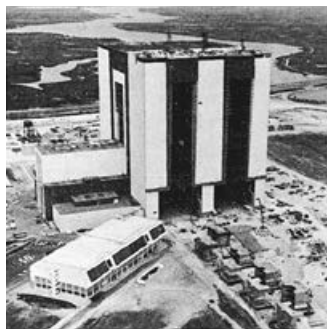
il fronte ovest con i vani per i razzi aperti e chiusi / west facade with rocket bays open and closed
