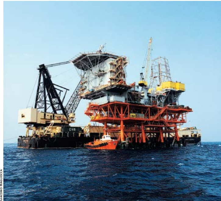
installazione del modulo alloggi / living quarters installation
