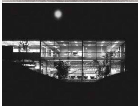
Patscentre Research Laboratory, Melbourn, Regno Unito, 1976-83 particolare di un fronte / detail of a facade
