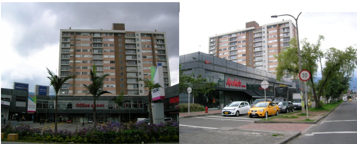
Fuente: Elaboración propia – fotografías tomadas en marzo de 2014. Avenida Carrera 68- Calle 98.
