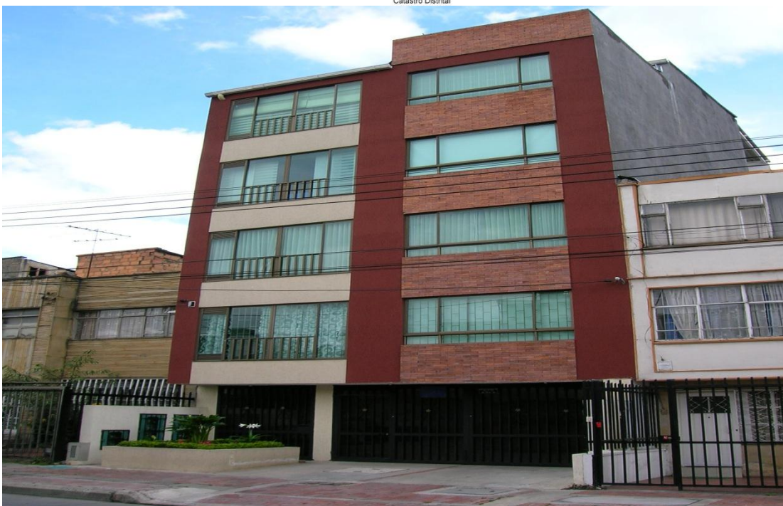
Fuente: Elaboración propia – fotografías tomadas en marzo de 2014. Edificio San Nicolás Calle 67 No 30A 18.
