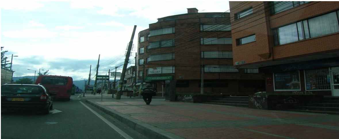
Fuente: Elaboración propia – fotografías tomadas en marzo de 2014. Avenida calle 100 Transversal 43.
