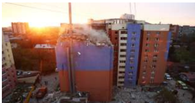
Рис.3. Разрушенные верхние этажи жилого дома после взрыва бытового
