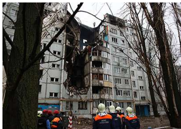
Рис. 2. Обрушение подъезда дома после пожара.
