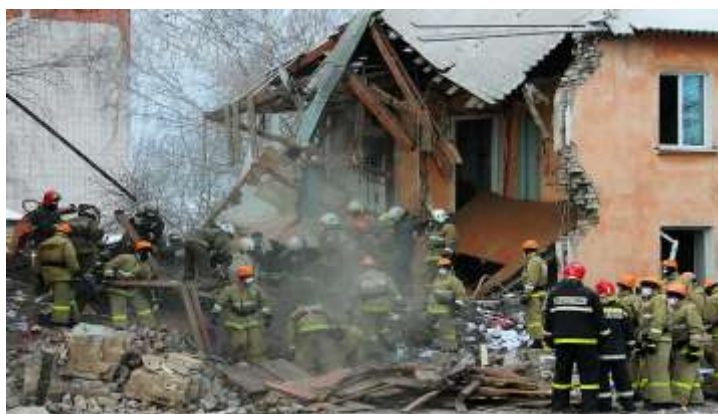
Рис.4. Обрушение двухэтажного дома после взрыва бытового газа.
