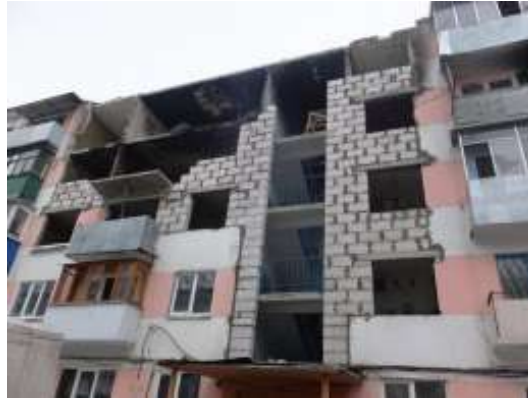
Рис.8. Процесс восстановления дома после взрыва и последующего пожара.
