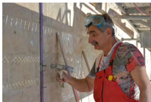
Figure 16 – Les éléments en plomb de 1683 sont fixés avec les vieux clous.
