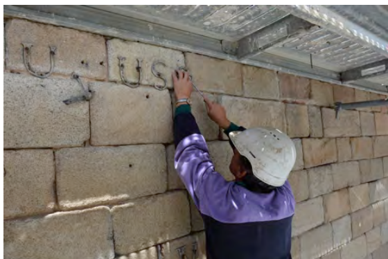
Figure 2 – Dépose, ce même jour des éléments en plomb de 1683 encore en place.
