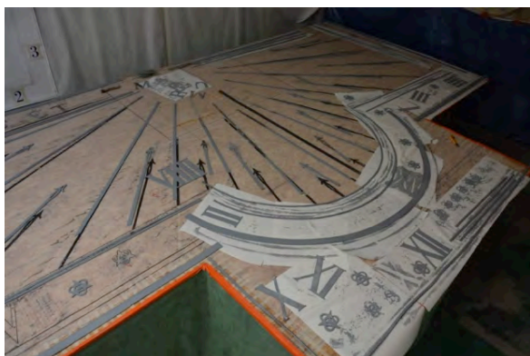
Figure 10 – Une couche de primaire d'accrochage est passée en préparation du fond.
