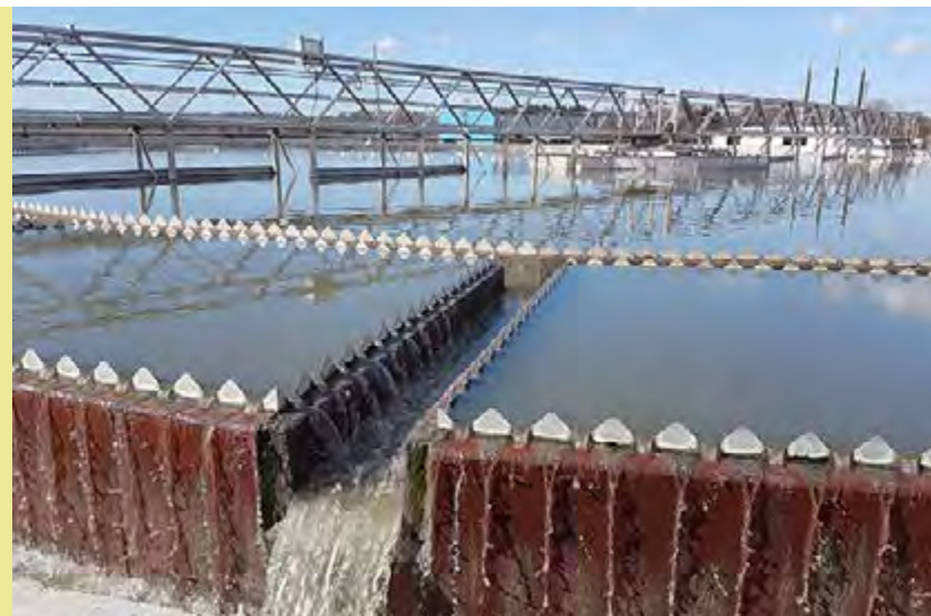
Foto: SWECO. Beskrivning: Ett nybyggt reningsverk i Kaliningrad, Ryssland.
