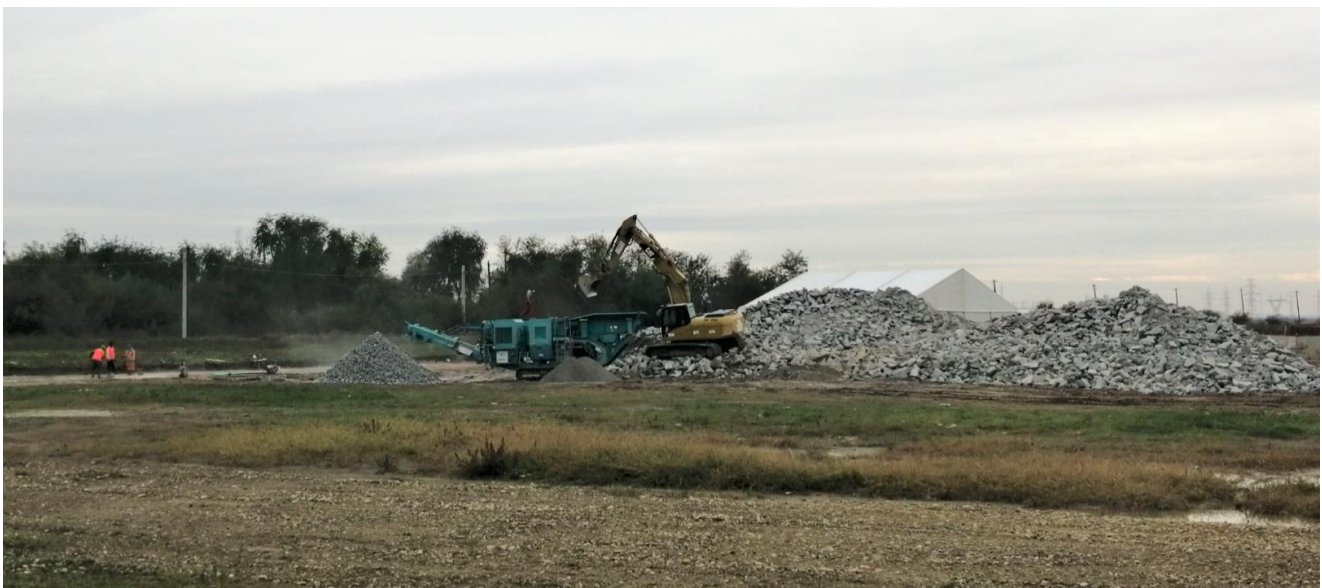
Εικόνα 4. Απόβλητα από σκυρόδεμα που έχουν υποστεί επεξεργασία και χρησιμοποιούνται ως επιχώματα σε εργοτάξιο στη Ρουμανία (Φωτογραφία: Rodica Stanescu, 2021)
