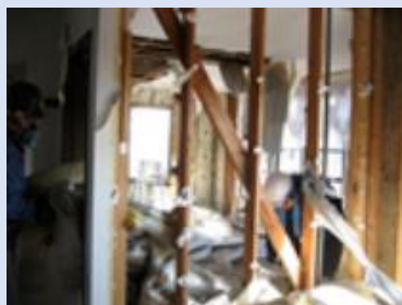
Αφαίρεση μονωτικών υλικών με το χέρι
