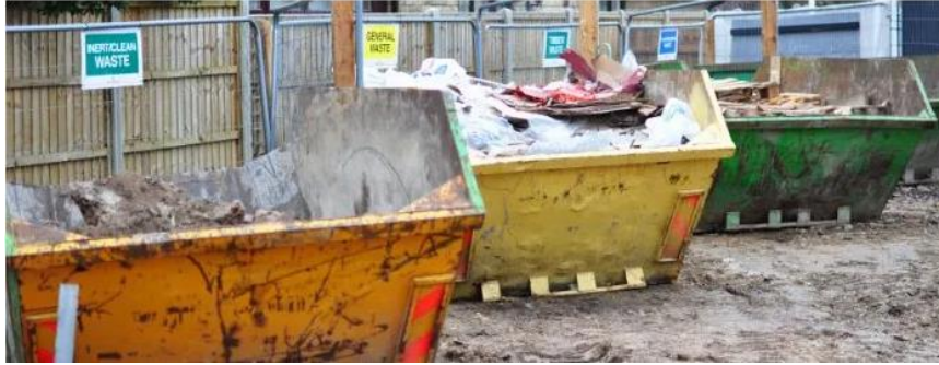
Εικόνα 1: Παράδειγμα προσωρινής αποθήκευσης ΑΕΚΚ . Πηγή: [2]
