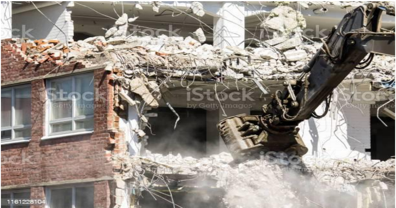
Συμβατική κατεδάφιση κτιρίου σε εξέλιξη
