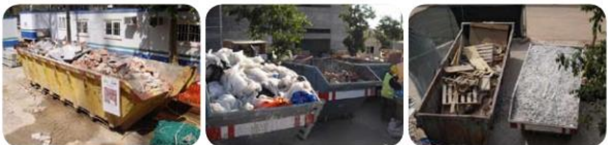
Διαχωρισμός αποβλήτων στο εργοτάξιο Πηγή : Ihobe public company for environmental education. Ihobe manual for drafting and implementing a construction and demolition waste management plan and good trade practices. 2012
