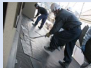
Αφαίρεση υλικών οροφής με το χέρι
