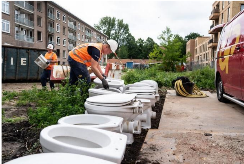
Εικόνα 3: Παράδειγμα διαδικασίας αποσυναρμολόγησης κυκλικής κατεδάφισης. Φωτογραφία: Erik Boschman. Πηγή: [8]
