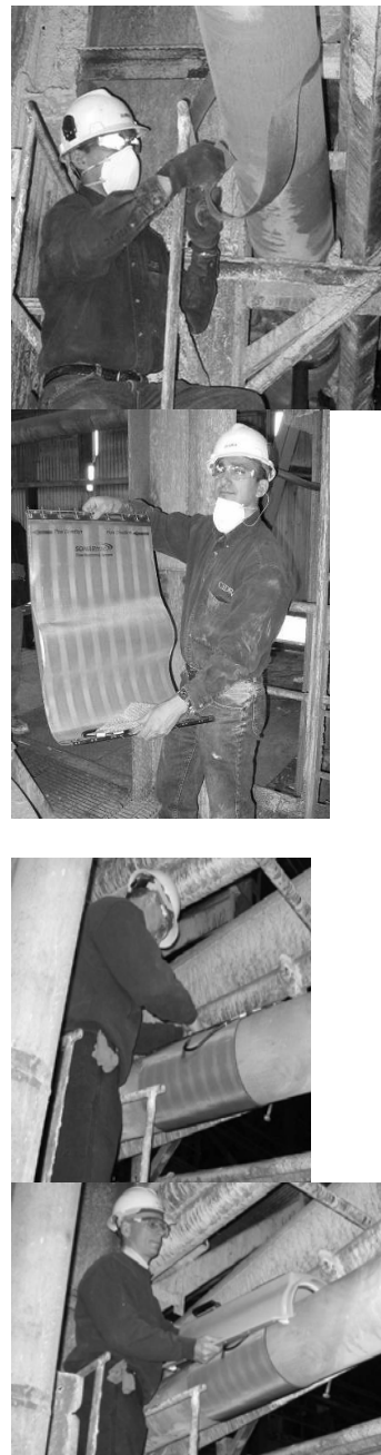
Figura 4 Procedimiento de Instalación a) Preparación de cañería b) Banda del sensor c) Instalación de la banda en la cañería d) Instalación de la cubierta del sensor
