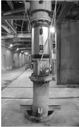
Figura 8 Flujómetro basado en arreglo sonar muestra vida útil > Cañería
