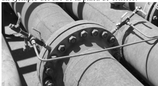
Figura 5 Medidor de flujo de placa de orificio y tipo invasivo con conexiones de presión.
