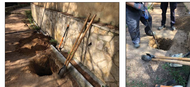
Fotografia 5 i Fotografia 6. Detalls de la realització de les cales manuals.
