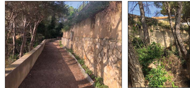
Fotografia 1 i Fotografia 2. Detalls de la zona del camí estudiada i detalls dels murs existents.
