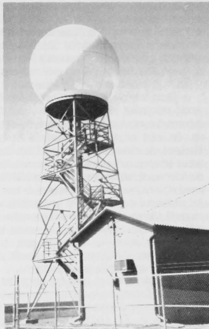
Installation du radar météorologique au Nouveau-Brunswick. Le seul ennui véritable est survenu quand l'opérateur de la grue a eu du mal à enlever le radome, qu'on n'avait pas déboulonné.
